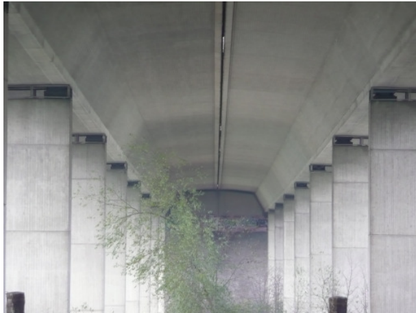
Abbildung 61: Beispiel Talbrücke mit Längsfuge
