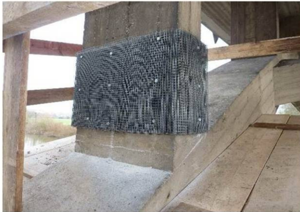
Abbildung 79: Nachträgliche DUCON®-Vorsatzschale
