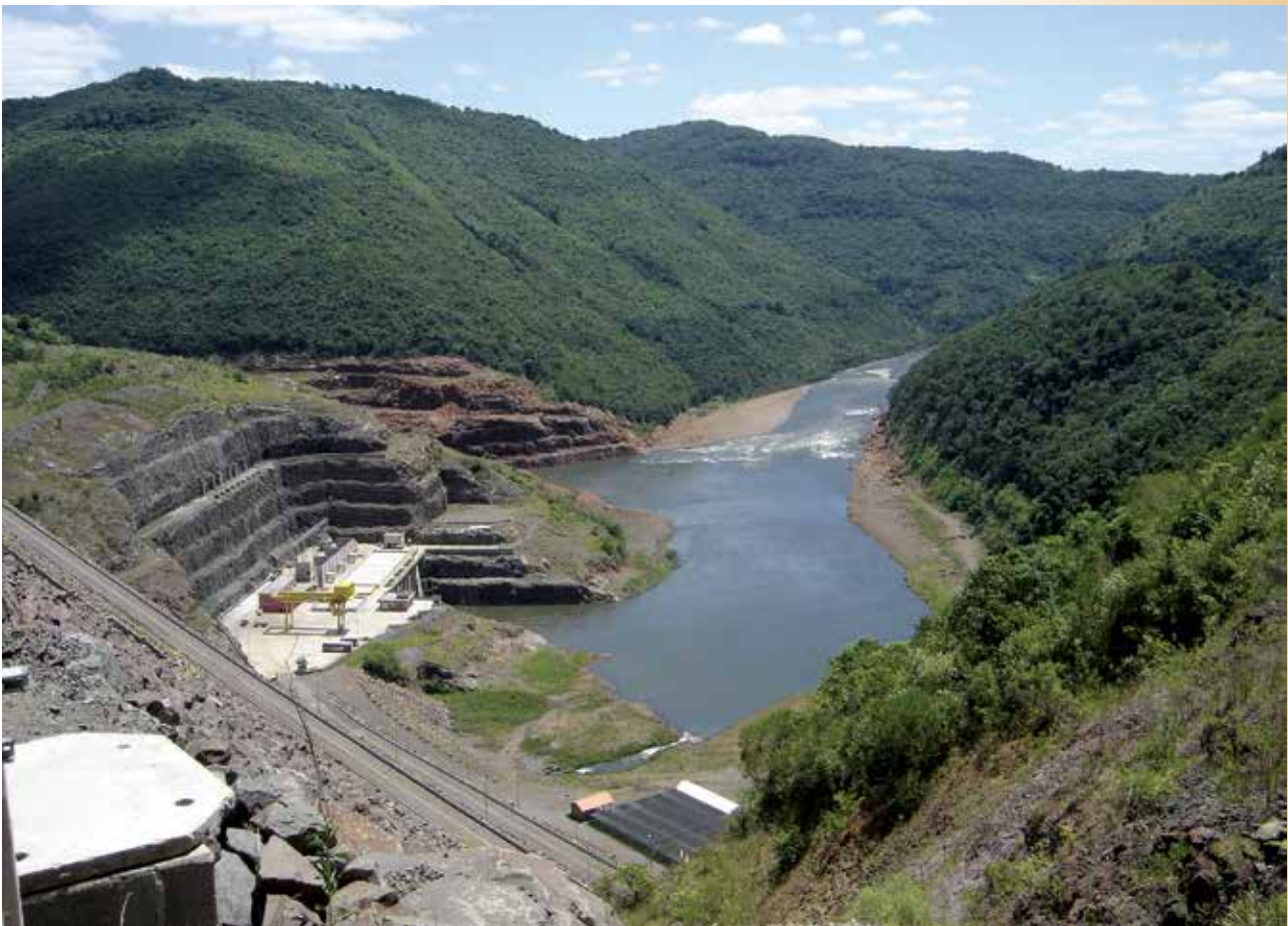
Figura 10a: Usina Hidrelétrica de Barra Grande, em Anita Garibaldi. FOTO: MARCIO VERDI
