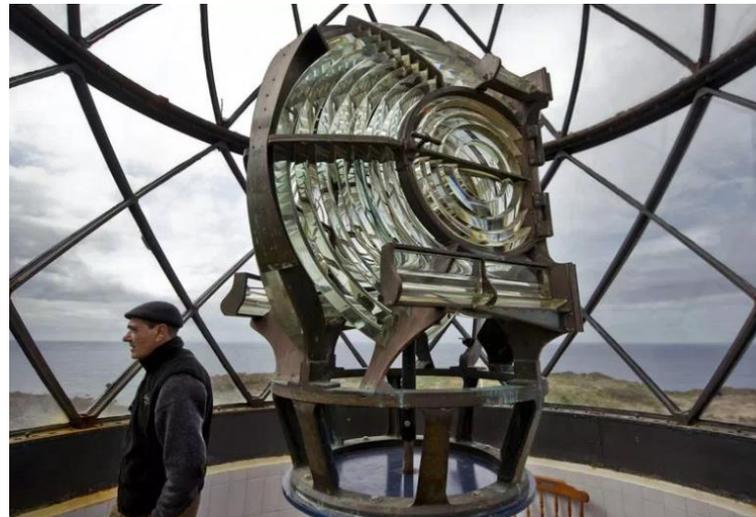
*Técnico Mecánico de Señales Marítimas y lente Fresnel (faro de Estaca de Bares).*
