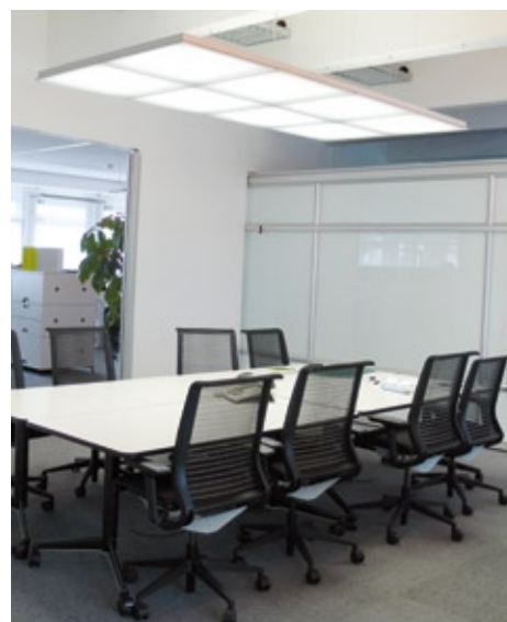
Bei Anordnung von acht Leuchten sind drei Kupplungssets erforderlich.
