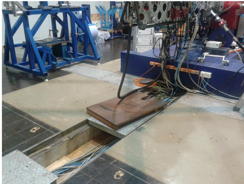
Abbildung 6.2: Verlegen der Signalkabel
