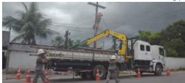
Paralisação é necessária para que sejam realizados serviços de manutenção
