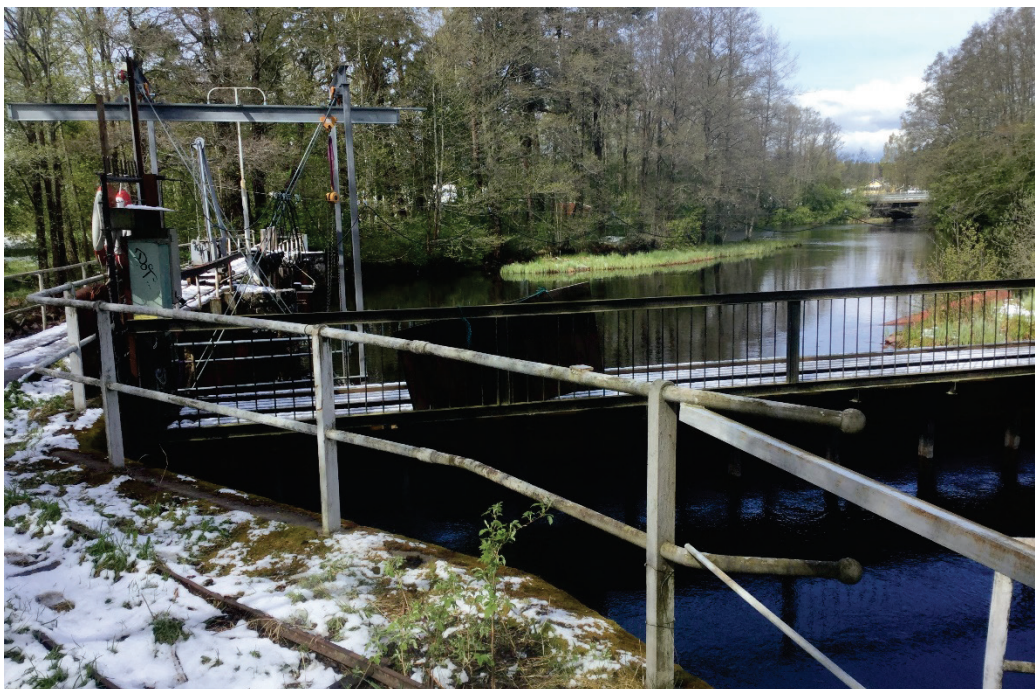
Figur 3. Vy över kraftverksdammen i Strömsbro med intaget till fiskpassagen och tillhörande fiskräknare vid dammens hitre del.
