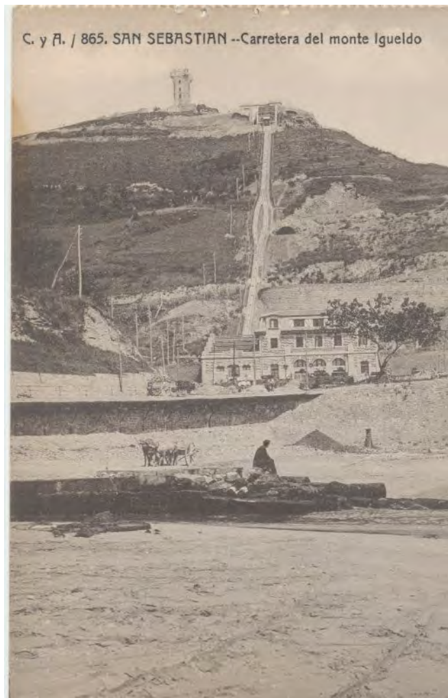
Vista desde la playa del monte, en los primeros momentos de la construcción de la zona.-
