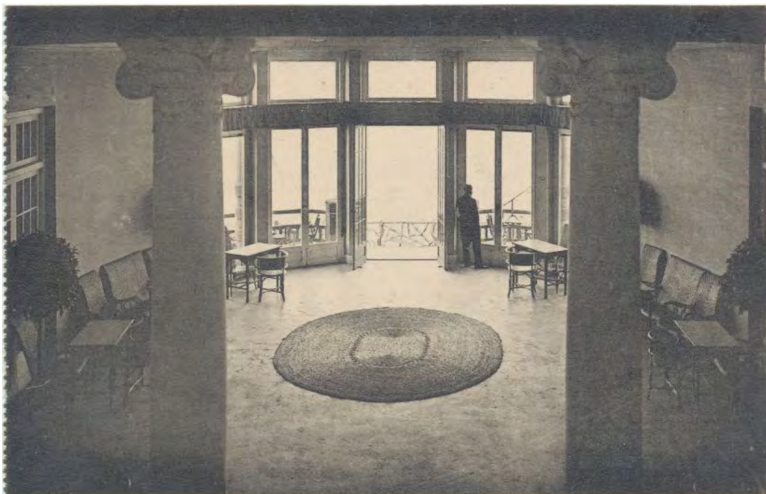
Salón ubicado en la parte baja del mirador central del edificio.-
