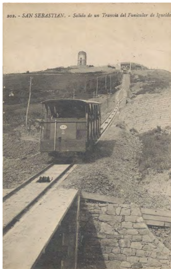
Al fondo los restos de la antigua "torre" antes de la reforma.-
