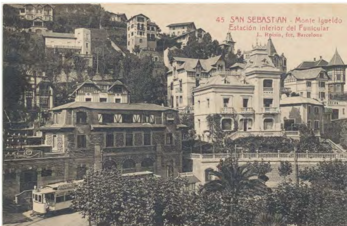
La ladera del monte ya exhibe casi todas sus construcciones, en la plaza un tranvía eléctrico.-
