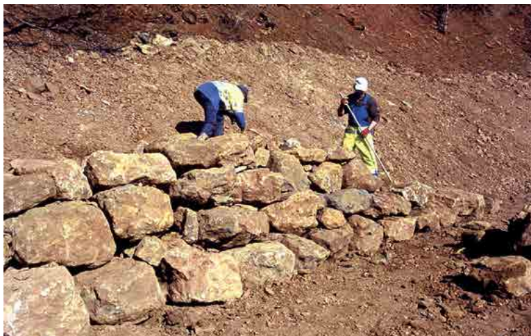
Abb. II.252: Bautätigkeiten an der geplanten Trockenmauer. (Ronneberg 18.03.2015; Foto: Josy Cungs).
