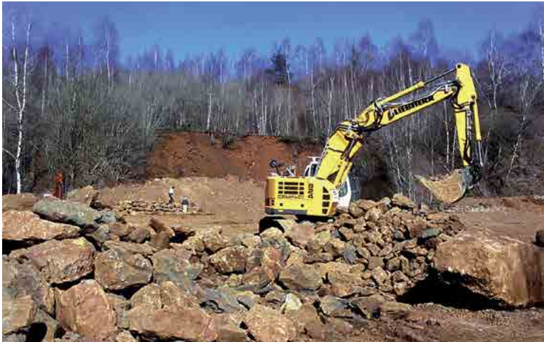
Abb. II.251: Selektion von Findlingen verschiedenen Kalibers zum Bau der gestalterisch einfühlbar in die Ausstattung des Gesamthabitats integrierten Trockenmauer. (Ronneberg 18.03.2015; Foto: Josy Cungs).
