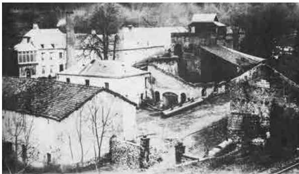
(Café des Saint Charles d'Haer, Le Comte). Les installations de La Sauvage en cours de démolition (vers 1900). On reconnaît: le 1 er haut fourneau de forme ronde et à l'arrière-plan le 2 e haut fourneau de forme carrée
