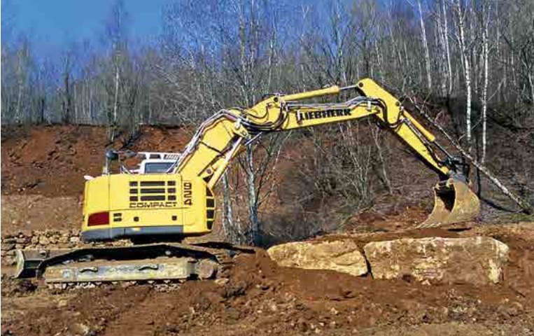
Abb. II.254: Aus einigen voluminösen Steinblöcken errichtete Ministeilwand als Habitatstruktur für Reptilien und Wildbienen u.a. (Ronneberg 18.03.2015; Foto: Josy Cungs).
