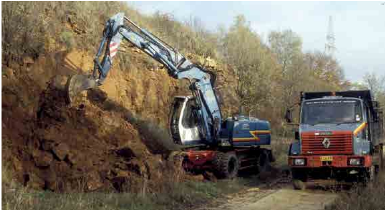
Abb.X.8.a: Freistellungsarbeiten der Abbruchkante
