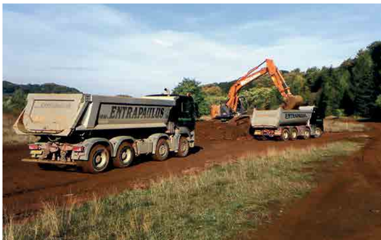
Abb. II.241: Findet sich direkt bei der Abhumisierungsfläche keine direkte Ablagerungsstelle, bleibt nur der Abtransport des abgeschälten Erdmaterials. (Eisekaul 18.10.2013; Foto: Josy Cungs).
