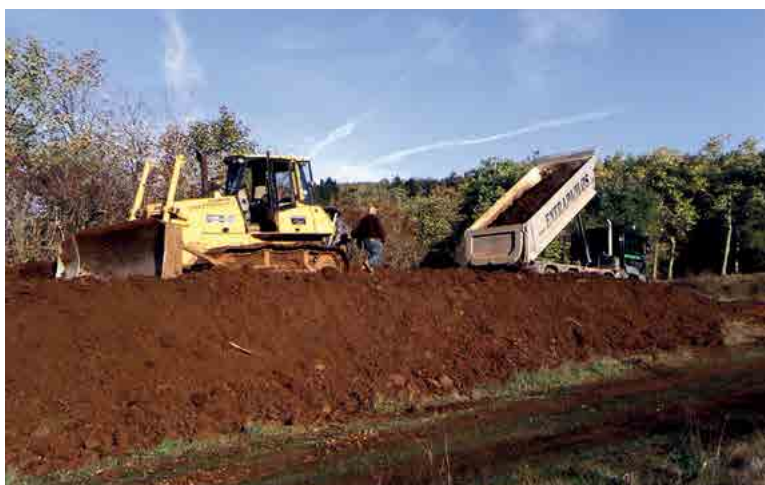
Abb. II.242: Um den finanziellen Aufwand des Erdabtransportes dennoch so gering wie möglich zu halten, wurde hier aufgrund der sich anbietenden Möglichkeit direkt vor Ort ein die bearbeitete Trockenrasenfläche abschirmender Wall entlang einer mäßig befahrenen Straße aufgeschichtet. Der Anteil der mit Neophyten-Rhizomen ( Solidago canadensis , Lupinus polyphyllus ) durchmischten Erde wurde dabei probeweise in die unterste Schicht des Walls eingebettet. (Eisekaul 18.10.2013; Foto: Josy Cungs).
