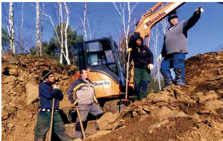
Abb. II.13: Vorarbeiter Pascal Eppe (Colabor) (rechts im Bild) gibt Instruktionen zu den verschiedenen Arbeitsabläufen und erklärt deren Sinn und Zweck. An diesem Standort musste zum Erreichen einer oberhalb gelegenen Fläche ein Wegzugang mit dem Kleinbagger geschaffen werden. (Lannebiert, NSG Haardt, 16.01.2011; Foto: Josy Cungs).
