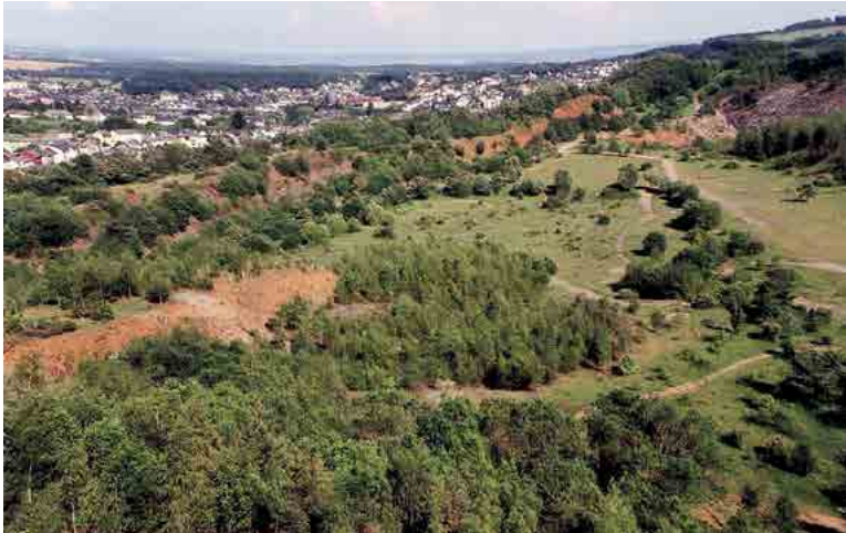
Abb. II.304: Teilbereich der ehemaligen Schlackenhalde von westlicher Richtung aus fotografiert. Das Gesamtgebiet liegt in direkter Nähe zum NSG Haardt, lediglich getrennt von der restlich verbliebenen und als Schutzwall dienenden Schlackenhalde. (Carrière Cloos 21.05.2012; Foto: Josy Cungs).
