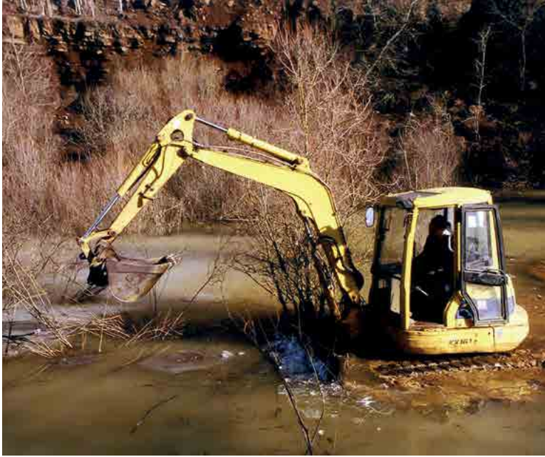
Abb. II.14: Das plötzliche, massive Eindringen von enormen Wassermengen in den zu Beginn der Entbuschung fast ausgetrockneten Weiher erschwerte die Arbeiten zunächst erheblich. Dennoch ergaben sich dadurch auch Vorteile. So wurden durch die über den Maschineneinsatz verursachten Wasser- und Schlammbewegungen die Fahrspuren des Minibaggers gänzlich verwischt. Gleichzeitig wurden die Rhizome der bereits etablierten Wasserpflanzen teilweise über die Fläche verteilt. Schließlich verkürzte die spätere Ansammlung von Geäst, Gehölz und Wurzelbruchstücken an einigen wenigen Stellen der Wasseroberfläche die Abschlussarbeiten. (NSG Kiemerchen 25.02.2009; Foto: Josy Cungs).
