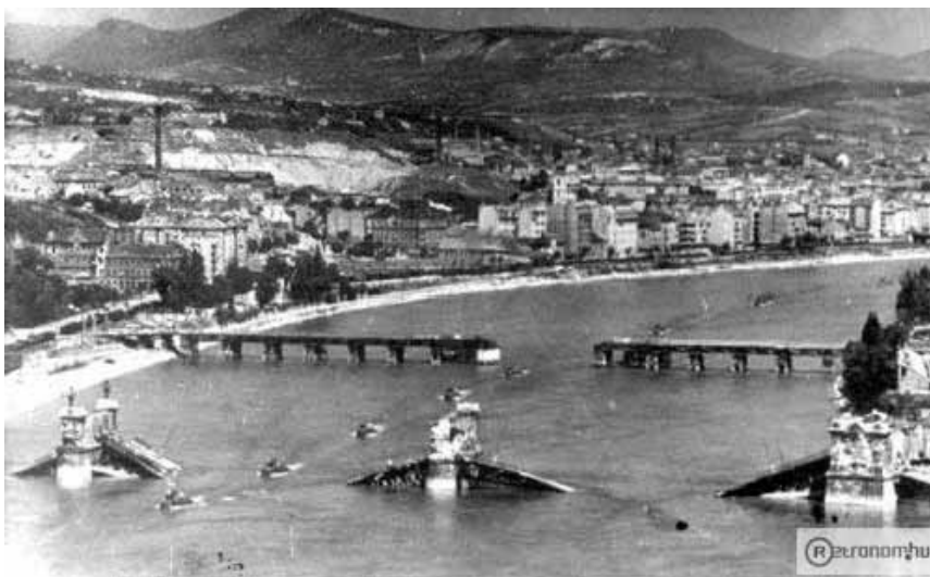
Manci cölöphíd a felrobbantott Margit hídtól északra épült meg
