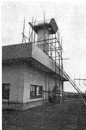
写真-10 根室電報電話局煙突外観
