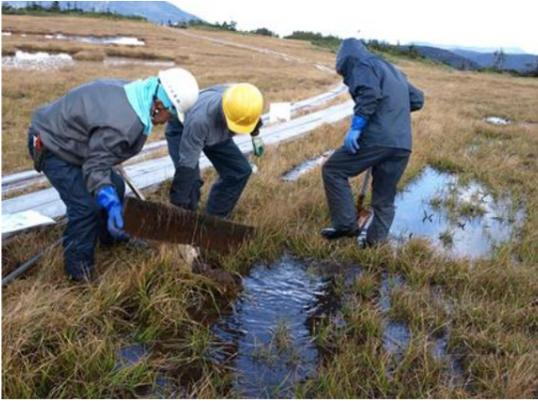
① 排水不良になっている箇所は、下側の土留板を撤去するなどして、排水路をできるだけ確保する (St. 09-01)
