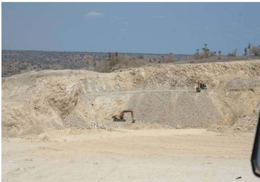
Foto 14. Construção no parque que levou a trabalhos de terraplanagem de grande escala.
