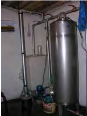
6.5 дугаар зураг. Өмнөдэлгэр сумын төвийн ус хангамжийн худагт тавьсан ус цэвэршүүлж цэнгэгжүүлэх төхөөрөмж
