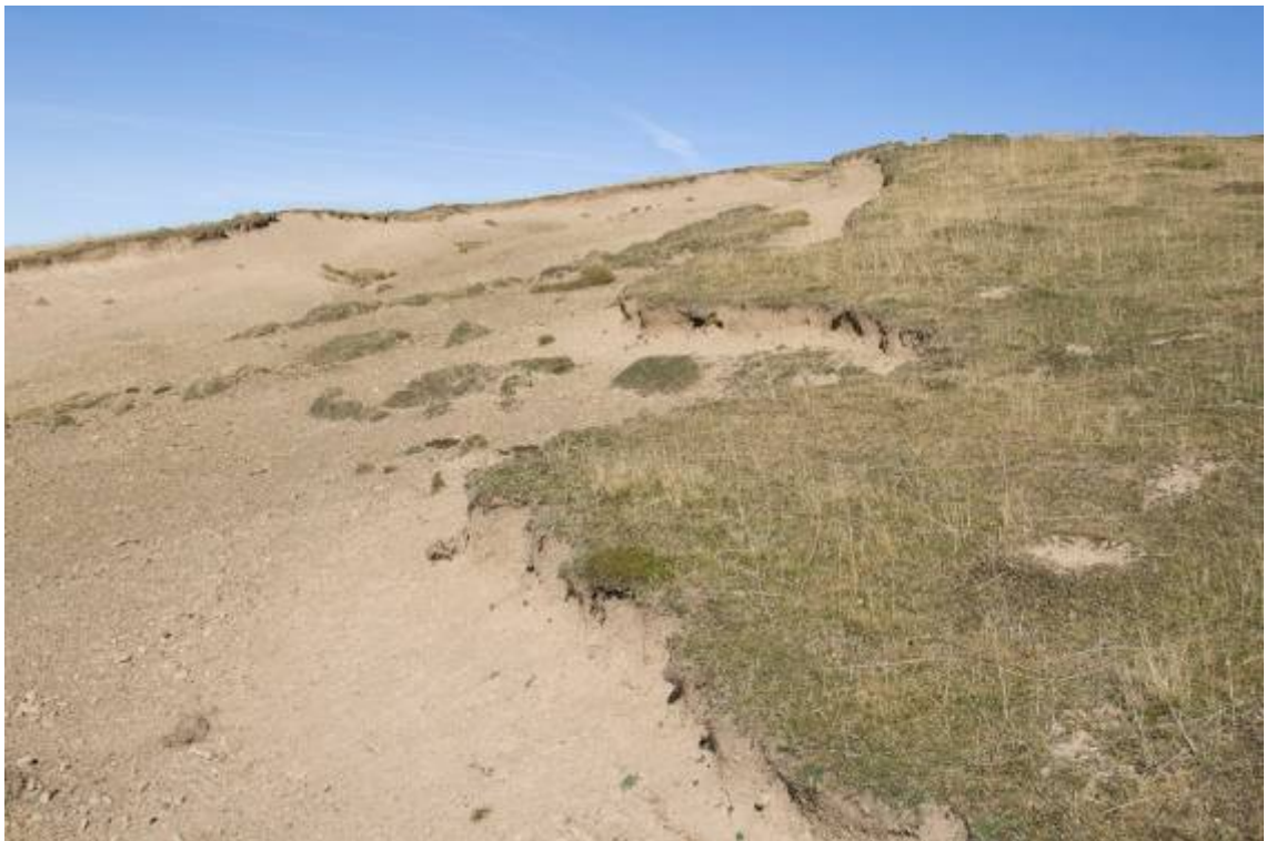
Zonas erosionadas en Arrigorrieta
