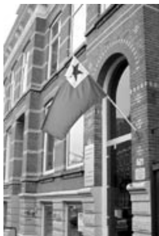
Sídlo UEA v Rotterdame.
