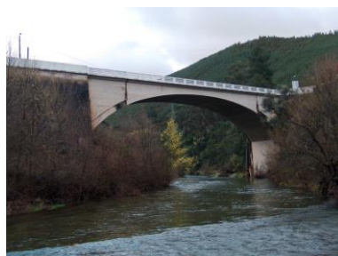
Foto n.º 79: Ponte construída sobre a Ribeira de Alvoco, E. N. 230, em Vide
