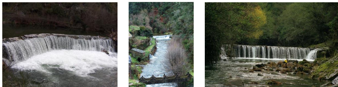
Fotos n.º 107, 108 e 109: Açudes nas Ribeiras de Loriga e de Alvoco, na freguesia de Vide
