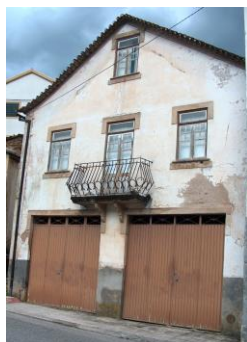
Foto n.º 11: 1.ª casa de habitação com garagem construída na aldeia de Vide
