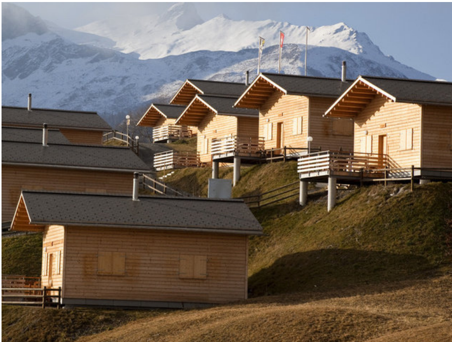
Aus: Zeitung Südostschweiz, 21.09.2010 (Ferienchalets am Heinzerberg),
