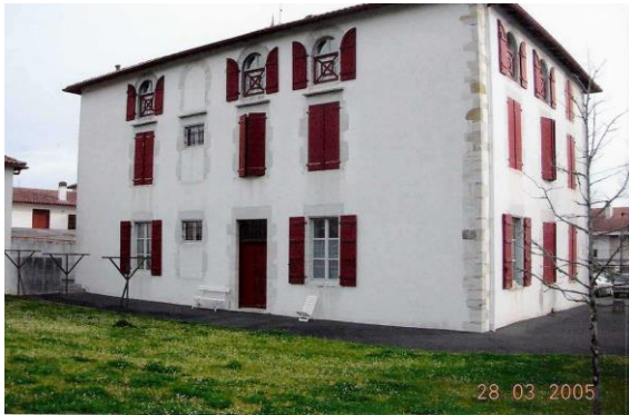
Figura 106 Casa Garatenea - Arauco
