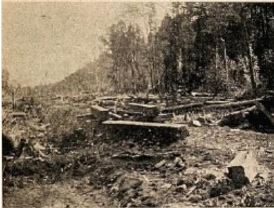
Figura 98 Terraplen para clavar los rieles en el kilómetro 15
