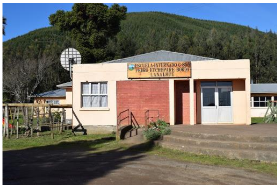
Figura 85 Escuela Internado Pedro Etchepare Borda en Lanalhue
