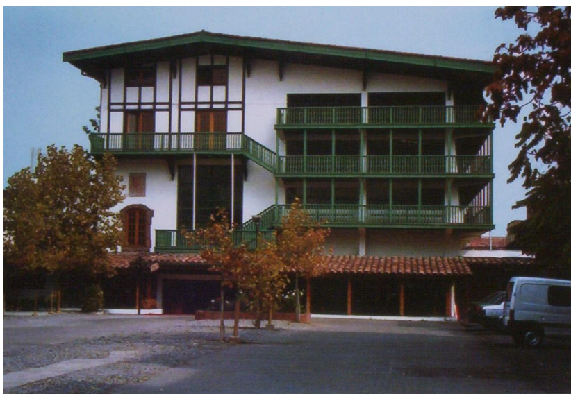
Figura 158 Centro Vasco de Santiago, en calle Vicuña Mackenna, (foto año 2004)
