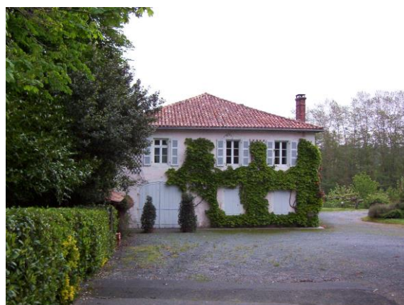
Figura 111 Casa Etchebertzea – Construida por Charles Etchegaray de regreso a Francia en 1865
