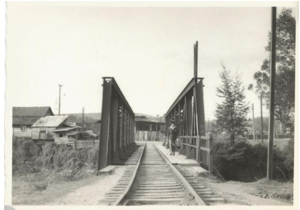
Figura 90 Construcción de puente
