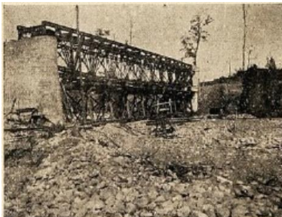
Figura 100 El puente sobre el río Quinchilca (del Creusot)
