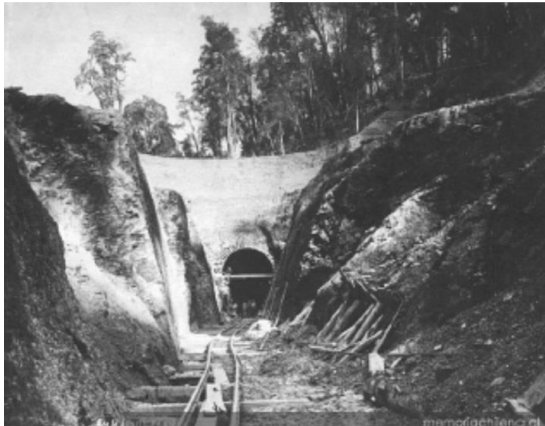
Figura 89 Construcción de túnel
