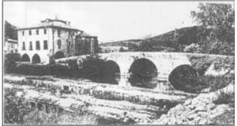
Navarra. Puente de la Trinidad de Arre (Ezkabarte) sobre el río Ulzama, en el camino de Santiago.
