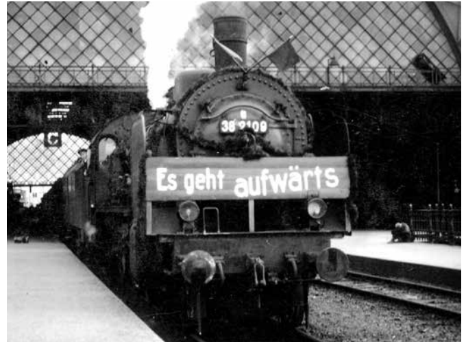
Eröffnungszug Görlitz-Dresden am 8.9.1945 nach Wiederinstandsetzung der Strecke, Dampflokom BR 38 mit Slogan „Es geht aufwärts“
