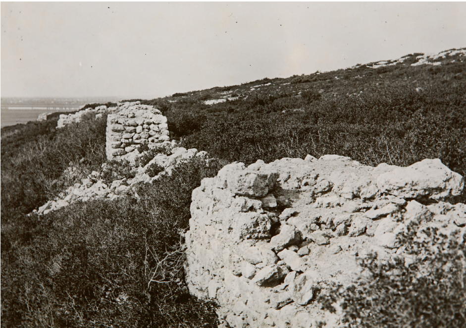
Le “rempart” barrant pour partie la montagne de Cordes.
