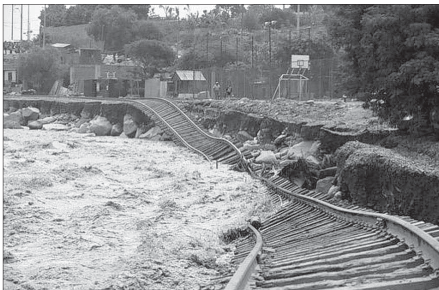
...Por mira aki reil di trein ku a keda destruí pa inundashonnan den e siudat Chosica na Lima...
