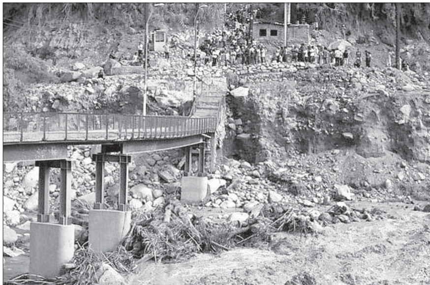
...Por mira hendenan para kantu di kaminda pegá ku un brùg ku áwaseru a kibra na Chosica..
