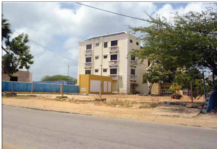
Konstrukshon banda di e tereno na unda a basha kas di hala abou.
