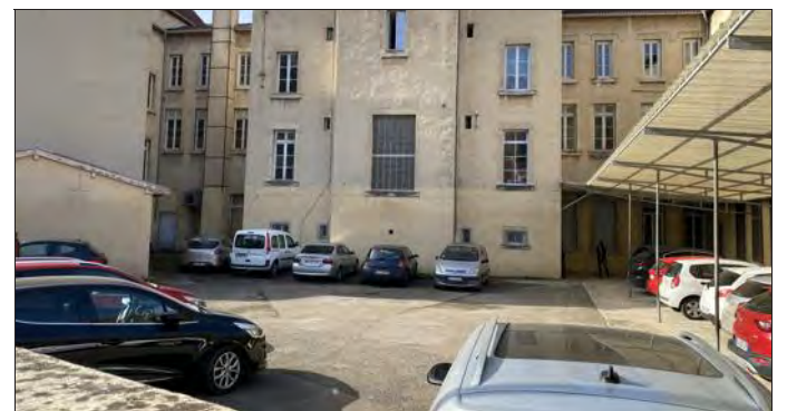
Le parking sera aménagé derrière la mairie et prolongé sur la droite, une fois le bâtiment du centre de loisirs détruit.
