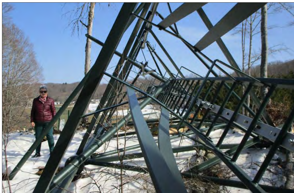
Le pylône de 40 mètres de hauteur a été déboulonné puis couché. Photo Progrès/Zenon NITKOWSKI
