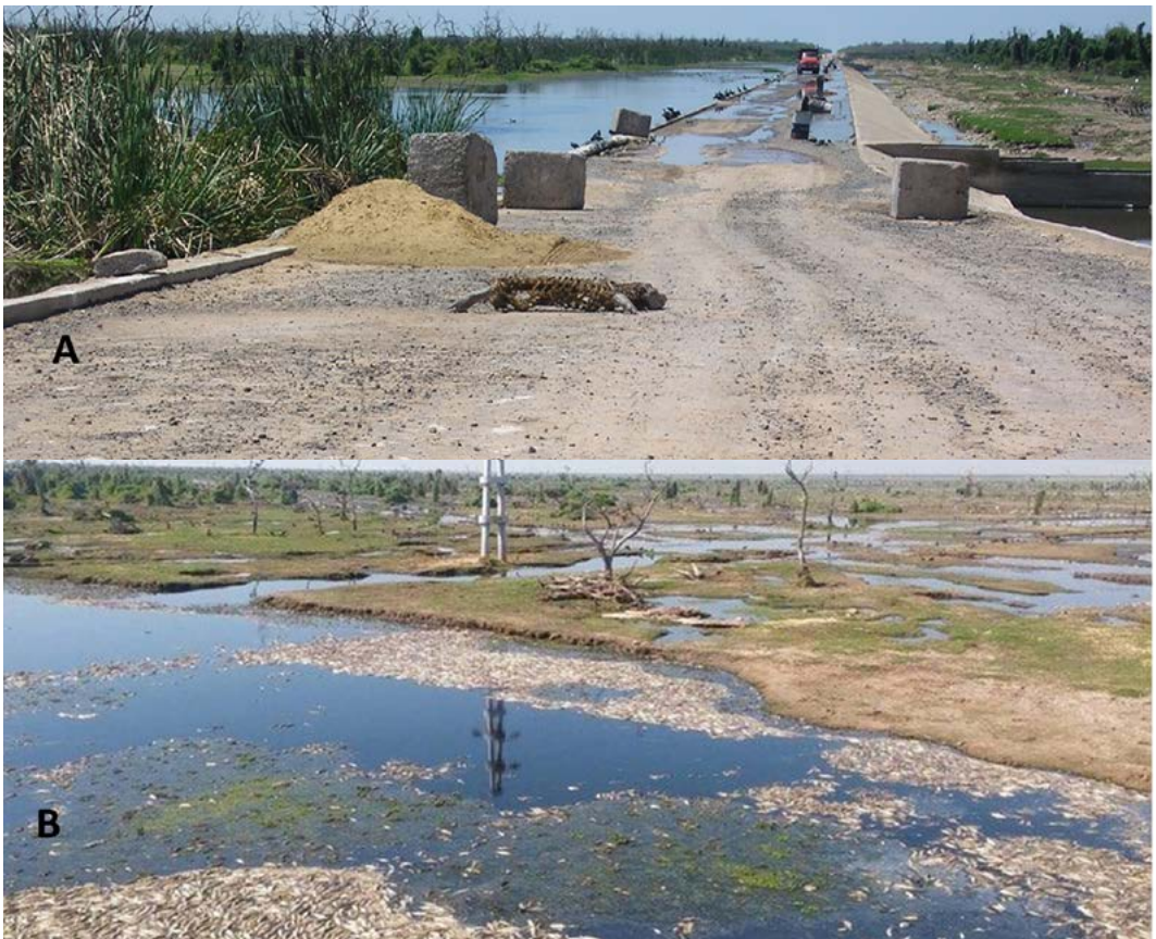
Figura 24. Vista de las condiciones del bañado en la ruta 28 en período de estiaje (A) y con zonas de aguas estancadas con peces muertos agua abajo (B)
