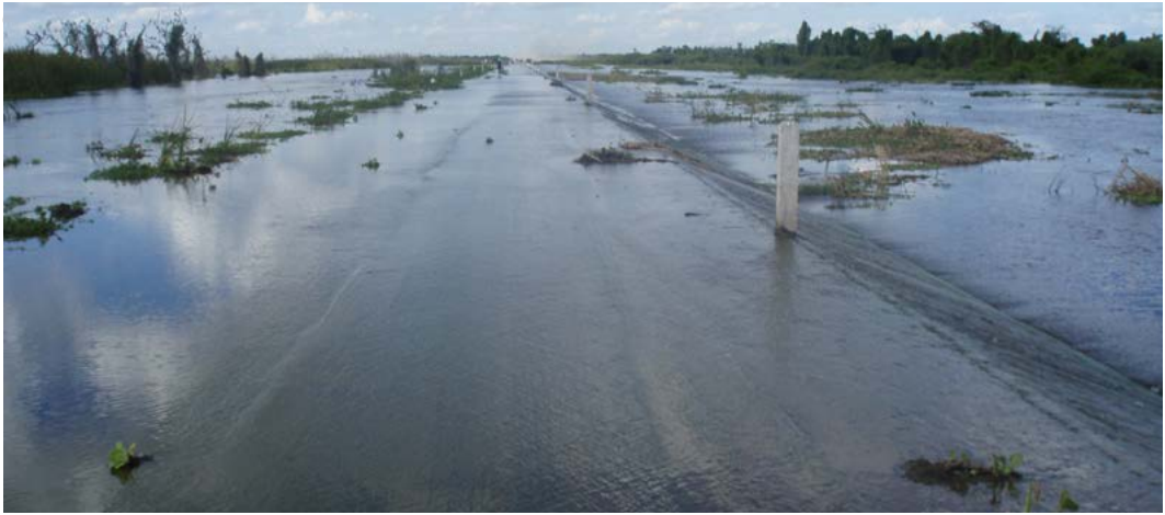
Figura 23. Vista de la ruta 28 en el bañado La Estrella. Su traza interfiere en la migración ascendente del sábalo durante el inicio del estiaje en que el nivel del agua del bañado comienza a bajar (Foto: Claudio Baigún).
