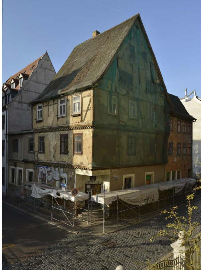
Abb. 1: Die sogen. Marktwirtschaft in der Brüderstr., Halle/Saale (2015), ein Fachwerkhaus des 16. Jhs. Die hölzerne Struktur des Gefaches ist an den Fehlstellen des Putzes in den oberen Stockwerken gut sichtbar. Das Fachwerk lag ursprünglich in Gänze unter Lehmputz (Foto: © J. Lipták, München)
