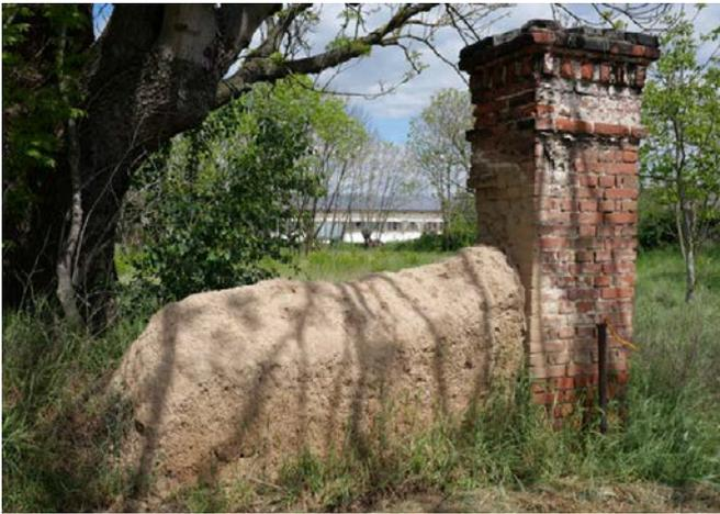
Abb. 13: Gewellte Umfassungsmauer eines Gehöfts in Großzöberitz, Saalekreis (2020). Die aus Ziegeln gemauerte Einfahrt ist erhalten, die daran anschließende Lehmmauer fließt von Jahr zu Jahr mehr ab (Foto: © F. Knoll, MLU)
