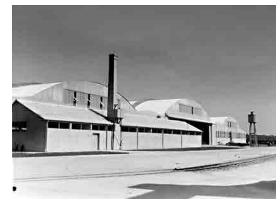
Vista geral das Oficinas Gerais de Aviação Naval.
