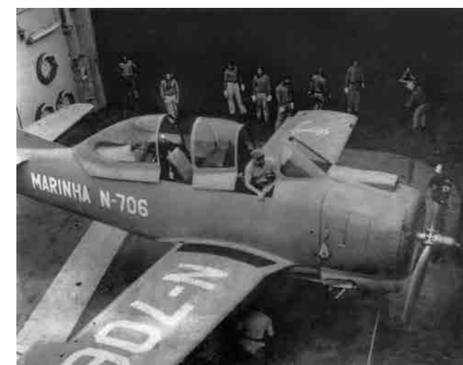
O T-28 era um excelente avião de instrução, mas sua operação embarcada sofria restrições. A mais grave era a falta de asas dobráveis que obrigava à completa remoção dos painéis externos para que o avião pudesse ser acomodado nos elevadores do navio, como ilustrado nessa foto.
