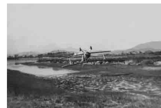
O Tenente Azevedo faz um rasante de dorso com um Pintassilgo, dentro da escavação para a construção da nova pista pavimentada do Galeão.
