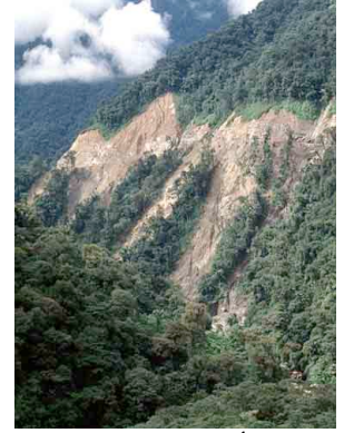
La Vía Interoceánica bajo construcción
