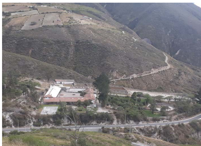
226 Vista de la Hacienda Tanlahua, cuya construcción y alrededores constituyen un bien patrimonial.
