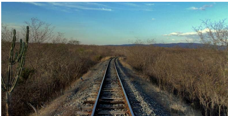
65 Malha ferroviária que corta a FLONA Photo: L. Marinho
