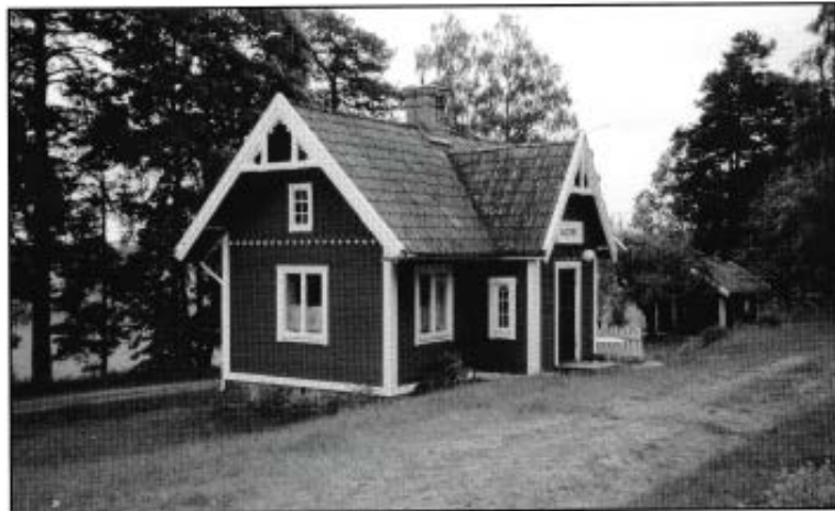
Averby vaktstuga, nr 4 år 1999. Den karakteristiska dragen finns fortfarande kvar trots att det är nytt tak, och nya fönster. Denna stuga hade en riktig källare under huset eftersom stugan ligger i sluttning. Banvallen kan ännu skönjas framför stugan
