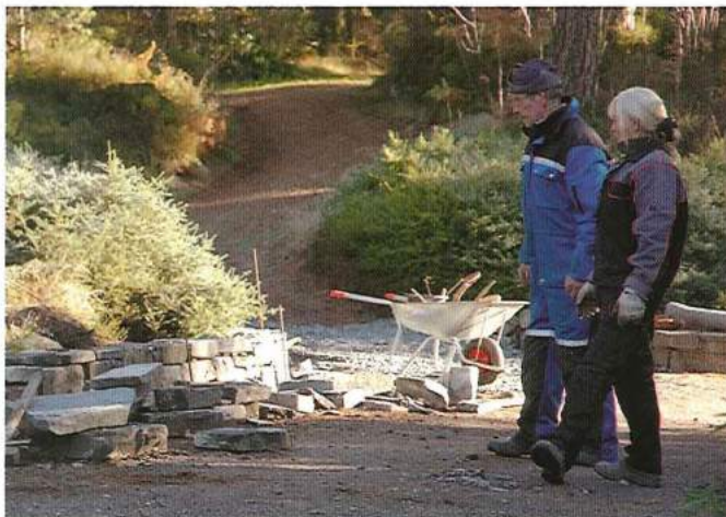
Muren langs veien til administrasjonen kommer på plass. Åsjørg Sätendal og Jon Inge Kleveland vurderer sitt verk (foto: B. Moe).
