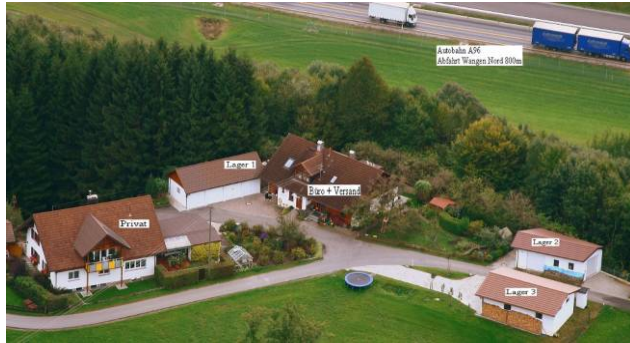
Luftaufnahme von 2009 der Fa. MERK Sicherheitstechnik mit A96
