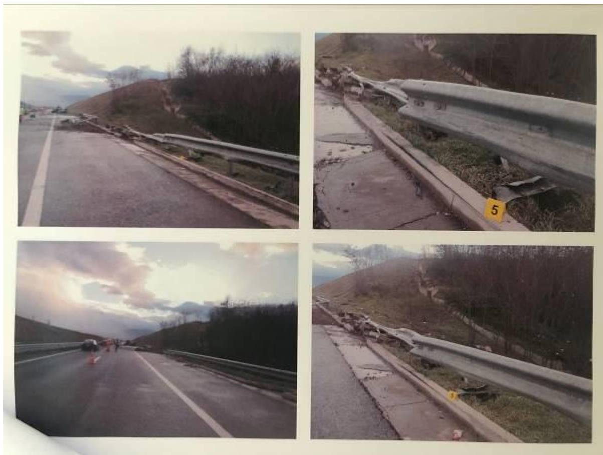
Figura 5.4a): Shiriti i djathtë i trafikut dhe pahitë elastike mbrojtëse të dëmtuara
