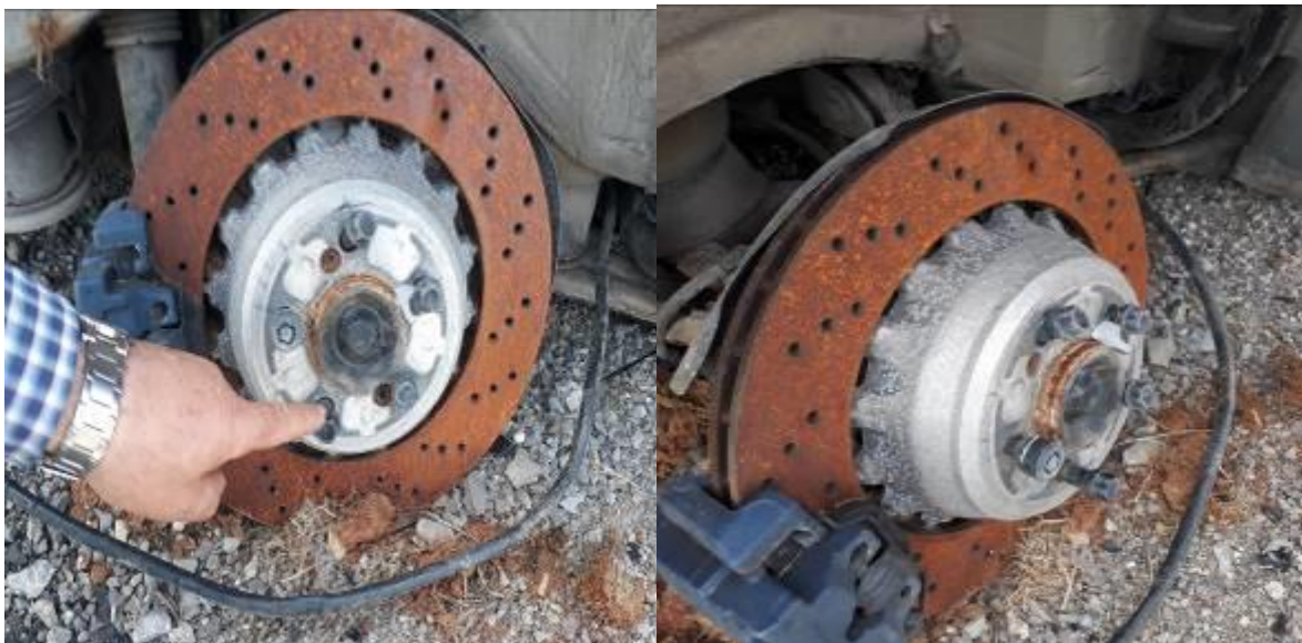
Figura 5.11. Verifikimi i gjendjes së bulonave të lidhjes së gjysmë boshitit të automjetit me rrotën e djathtë prapa
