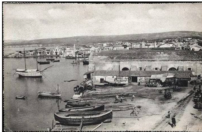
Σχ.Α4.Φωτογραφία των αρχών του 20ού αιώνα του χώρου μεταξύ των νεωρίων και του Τελωνείου. Ο δρόμος μπροστά από τα νεώρια δεν έχει κατασκευαστεί ακόμη.
