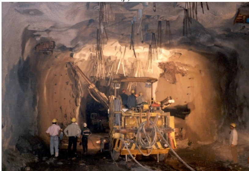
Σχ. 3.14. (α) Θολωτό μέτωπο (1) και βαθμίδα με ανεστραμμένο θόλο ή αντίστροφο τοξωτό δάπεδο (2) σε εγκάρσια (αριστερά) και διαμήκη τομή (δεξιά). (β) Ισομετρική άποψη του θολωτού -προπορευόμενου μετώπου, της βαθμίδας (bench) και του αντίστροφου τόξου (Invert), και (γ) κοχλίωση οροφής και παρειών της σήραγγας που είναι υποστηριγμένη με εκτοξευόμενο σκυρόδεμα.
