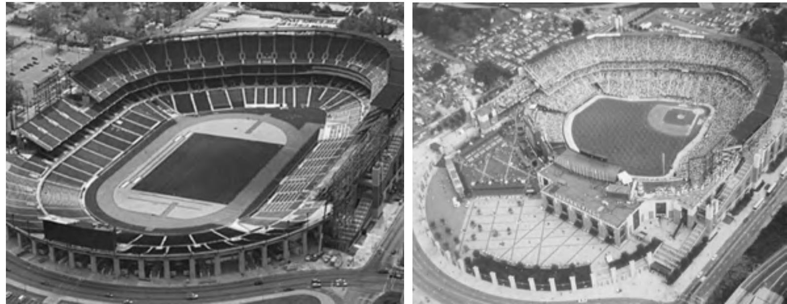
Fig.27 Per le Olimpiadi di Atlanta prevedeva la costruzione del Centennial Olympic Stadium che avrebbe ospitato tutte le gare di atletica e la cerimonia d'apertura e di chiusura della XXVI Olimpiade quella del centenario dell'istituzione dei giochi olimpici. Pensarono di disegnare l'impianto per poi essere riutilizzato come stadio di baseball permanente, come si può anche notare osservando l'angolo sudovest dello stadio, destinato a ospitare il diamante.
