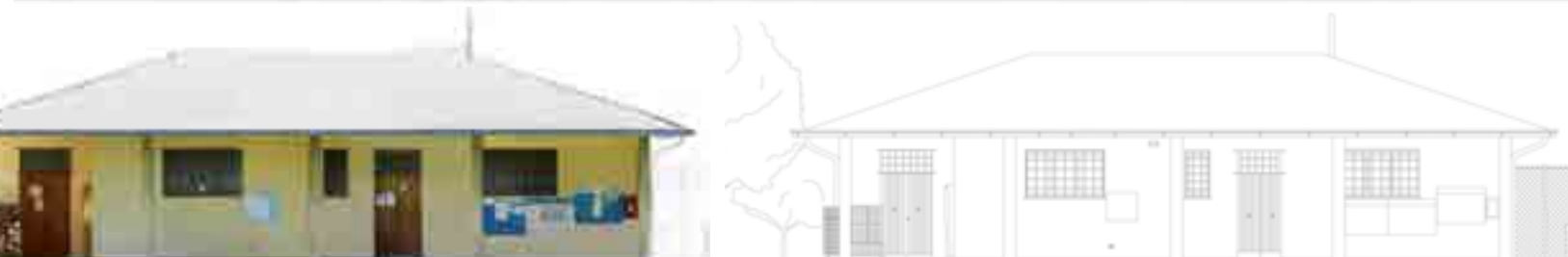
In fig._Nelle immagini si presenta lo stato di fatto dell'edificio, adibito a spogliatoio e con evidenziate le funzioni che caratterizzano i vari locali, dai fotopiani si evince i rimaneggiamenti e i danni impressi dal tempo e dall'uomo. La fotogrammetria ha da sempre un ruolo fondamentale e indiscusso come moderna e rigorosa tecnica di rilievo perchè ci aiuta a comprendere le vriticità che si presentano.
