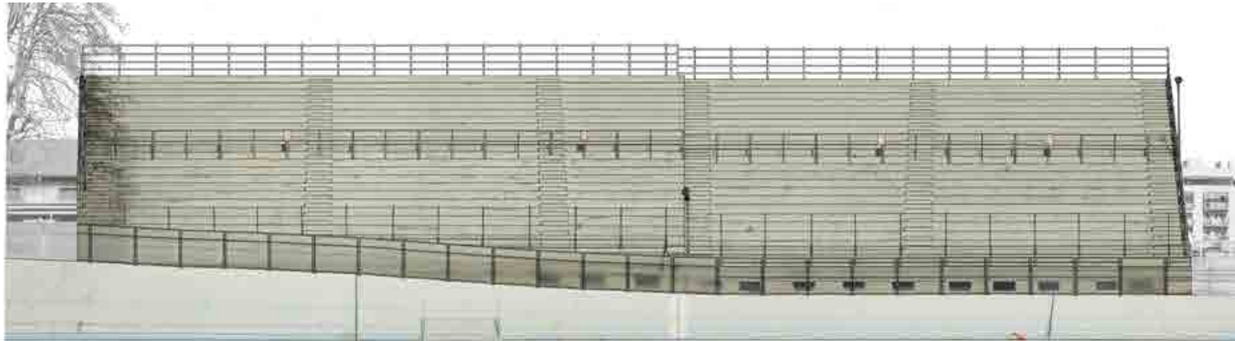
Fig._ Per l'acquisizione dei dati della tribuna del velodromo, vista la complessità, sono state previste campagne fotografiche suddivise per livelli di indagine. Una prima campagna ha previsto l'acquisizione della superficie della pista una seconda campagna è stata condotta da livelli progressivi, da un lato all'altro della gradonata su molteplici posizioni di ripresa. Successivamente il dato acquisito è stato integrato da una serie di riprese più dettagliate di ciascun elemento.
