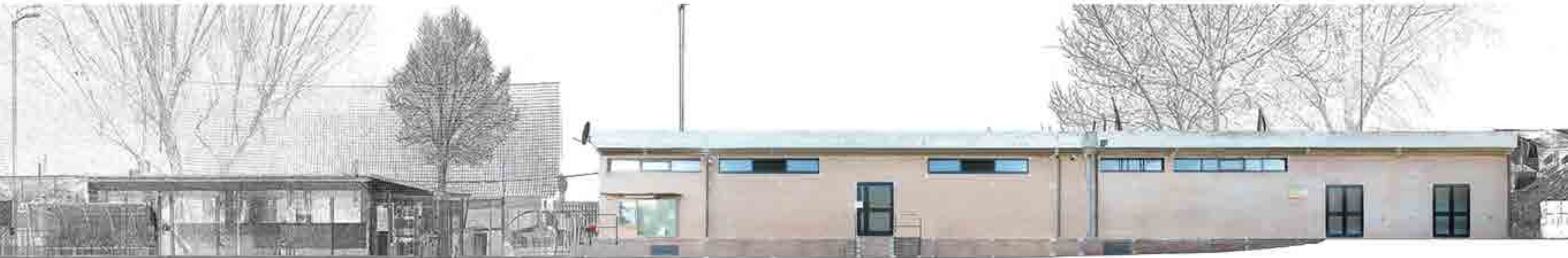
In fig._Ortofoto del fronte principale degli spogliatoi
