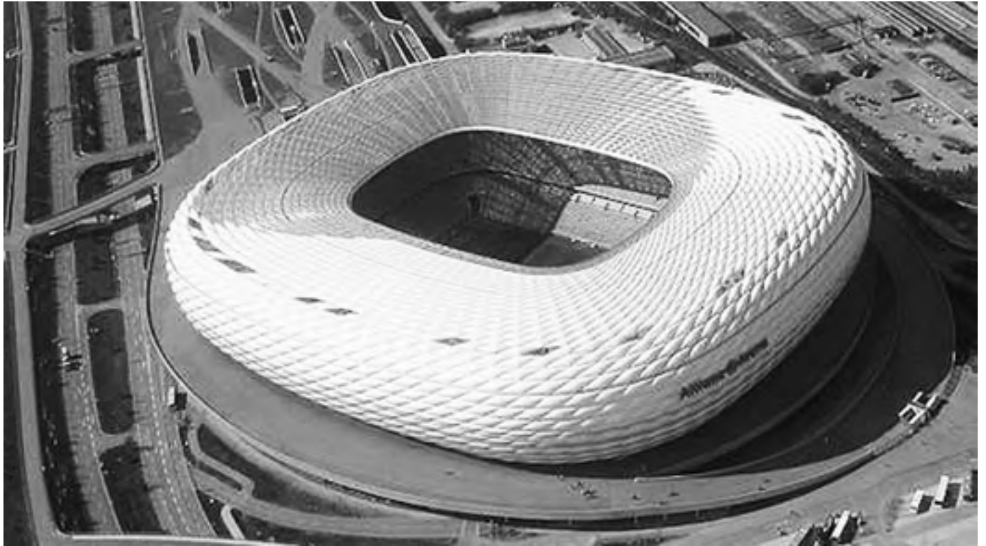
Fig.28 Lo stadio di Monaco è quanto di più moderno la Germania possa offrire, con i suoi quasi 70.000 posti a sedere e spazi riservati al tempo libero e allo shopping, accessibili anche nei giorni feriali
