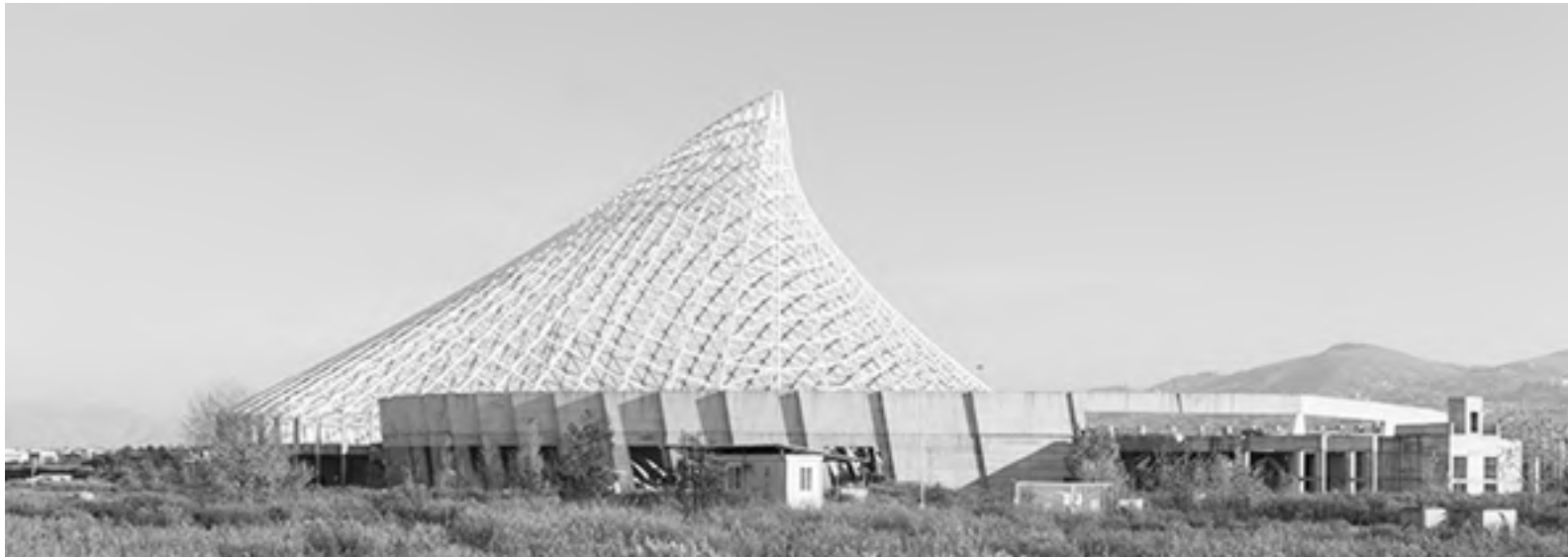
Fig.13_Foto dell'attuale condizione di precarietà e abbandono dello stadio.
