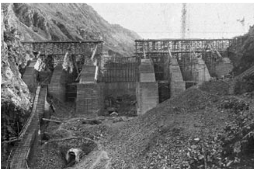
Diga di Venina in costruzione. Foto archivio Edison
