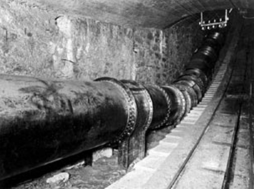
Piano inclinato in galleria Zappello-Montirolo. Foto archivio Edison
