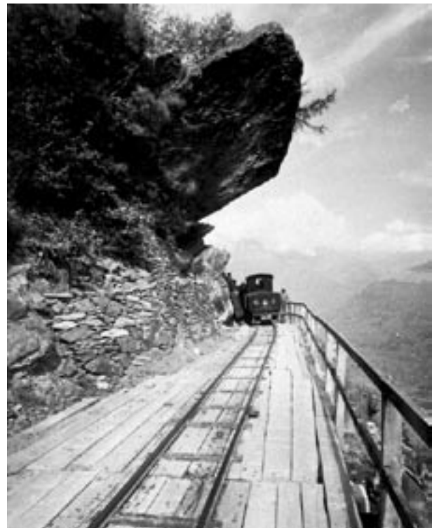
Val Venina: decauville Gaggio-Vedello. Foto archivio Edison
