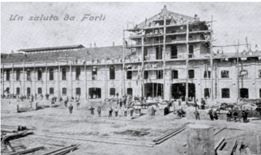
Lo zuccherificio Eridania di Forlì nel momento della costruzione.
