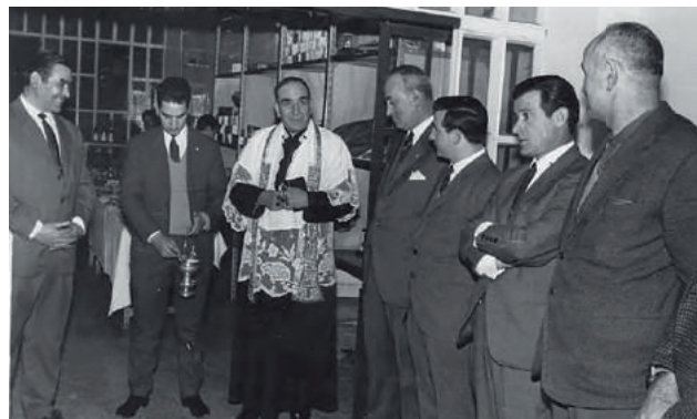
— Bendición de las remodeladas instalaciones de Barrenkale por el párroco de Durango
