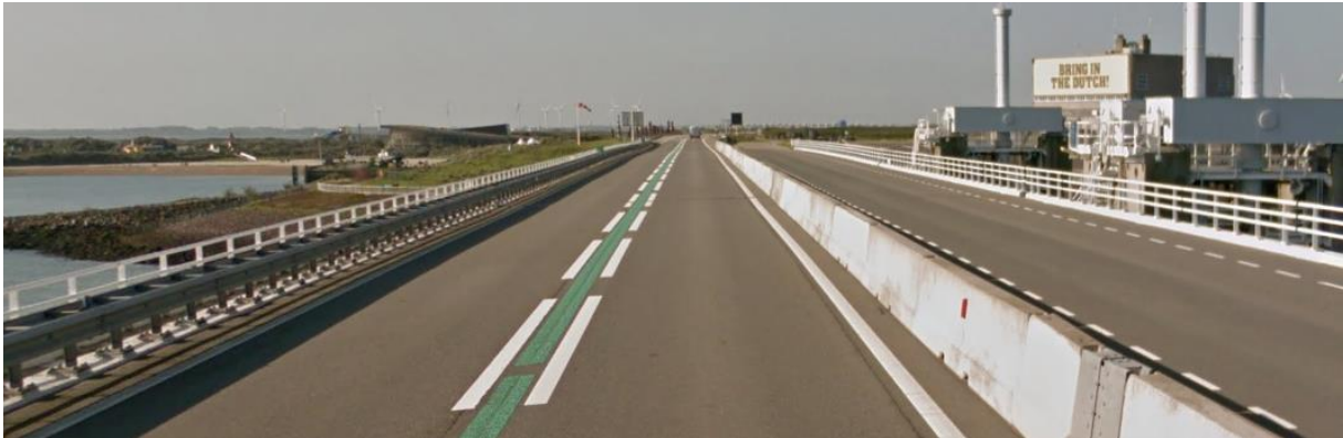
Figuur 3: EHK in de praktijk. Een naast elkaar gelegen SW (links) en ETW (rechts) op de Oosterscheldekering. (Google Streetview)
