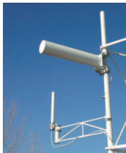
Ésta es una antena del tipo Yagi. ¿Alguien encuentra algún parecido?
