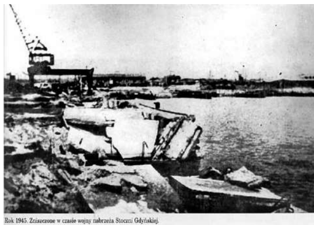
Rok 1945. Zniszczone w czasie wojny nabrzeża Stoczni Gdynińskiej.
