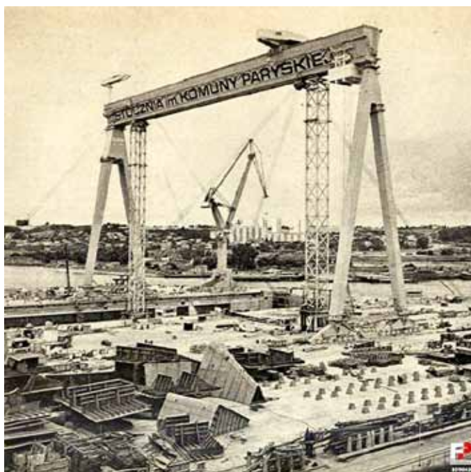
Fot. Przedstawia końcowy montaż suwnicy bramowej w SD II o unosie 900 ton przez fińską firmę „KONE” (Domena publiczna).
