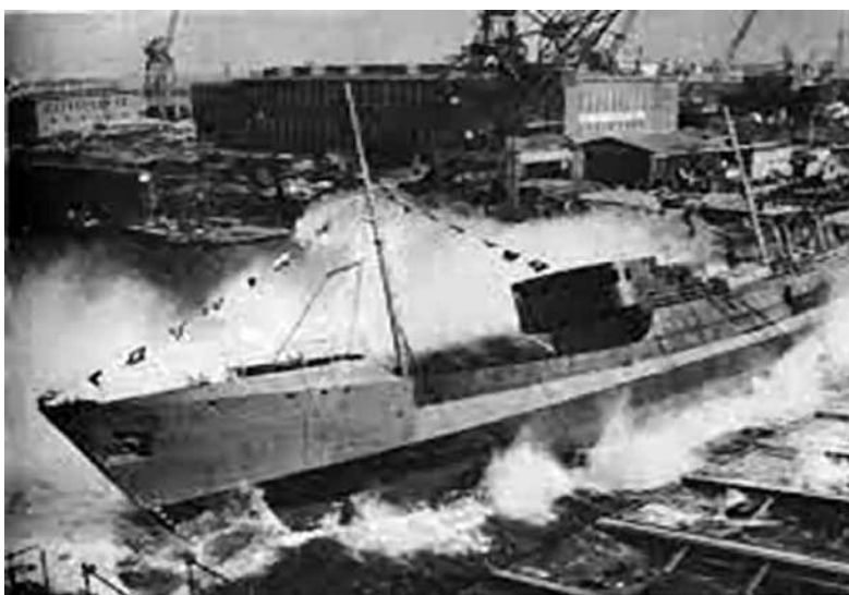
Fotografia przedstawia wodowanie na pochylni bocznej pierwszego pełnomorskiego statku w Stoczni im. „Komuny Paryskiej” w Gdyni statku „MELITOPOL” dla armatora z ZSRR.
