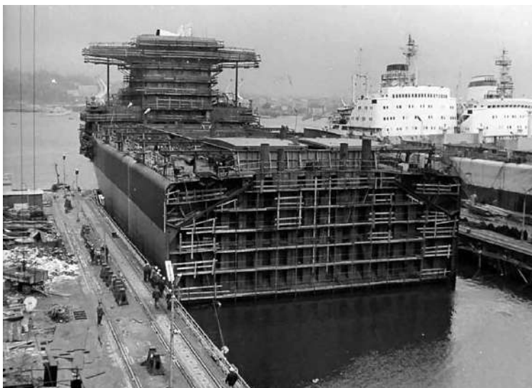
Powyzsza fotka przedstawia moment, w którym rufowa część kadłuba statku B-521/1 uzyskała pływalność i jest wyholowywana z doku nr 1.
