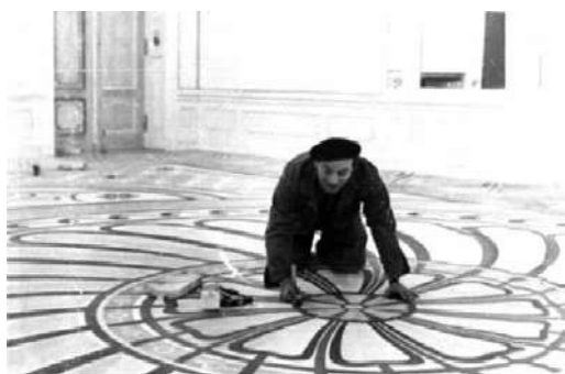
Powyższa fotografia przedstawia rzemieślnika (parkieciarza) nadającym ostateczny „szlif” parkietowi, ułożonego z rysunków traserskich Biura PKT stoczni
