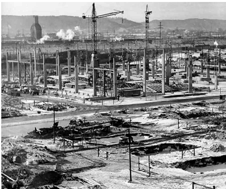
Powyższa fotka wykonana 28 XI 1961 roku przedstawia początkową fazę robót budowlanych. Stojące słupy na drugim planie to słupy przyszłej hali obróbki kadłubów Wydz. K-1.
