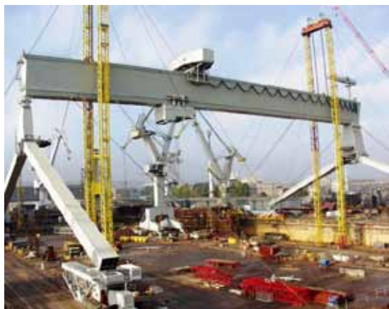
Montaż suwnicy przez holenderską firmę „Mammoet”
