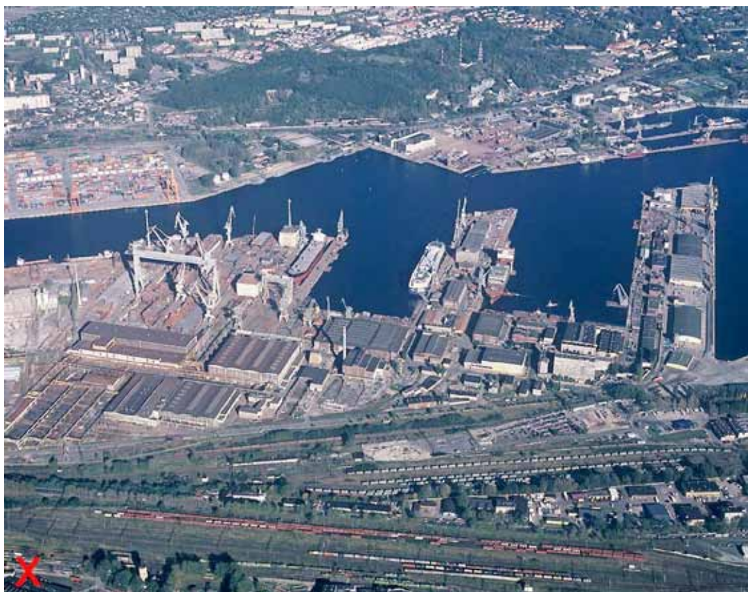
Widok stoczni z "lotu" ptaka już z zainstalowaną nową 1.000 tonową suwnicą bramową
