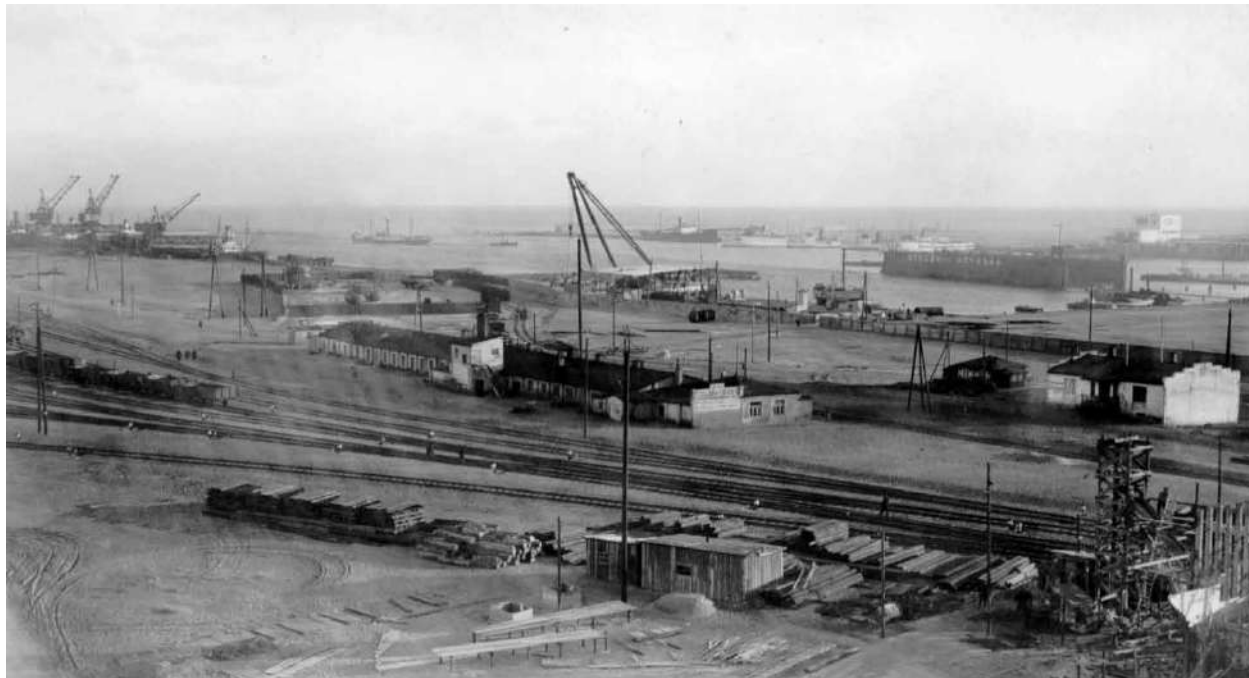
Widok na warsztaty Stoczni Gdynińskiej – po prawej stronie fotografii ... w oddali widać dok pływający z napisem „STOCZNIA GDYŃSKA”. Na bliższym planie budowa nabrzeża Śląskiego. (fotka ze zb. inż. Zb. Nowaka)
