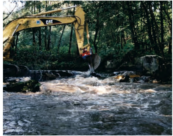
Wiederherstellung der Durchgängigkeit an der Mitternacher Ohe
