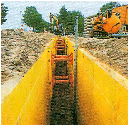
a.) Géppel készített árok dűcolás
