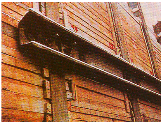
31. ábra: Siemens dúcolás hátrahorgonyzással
