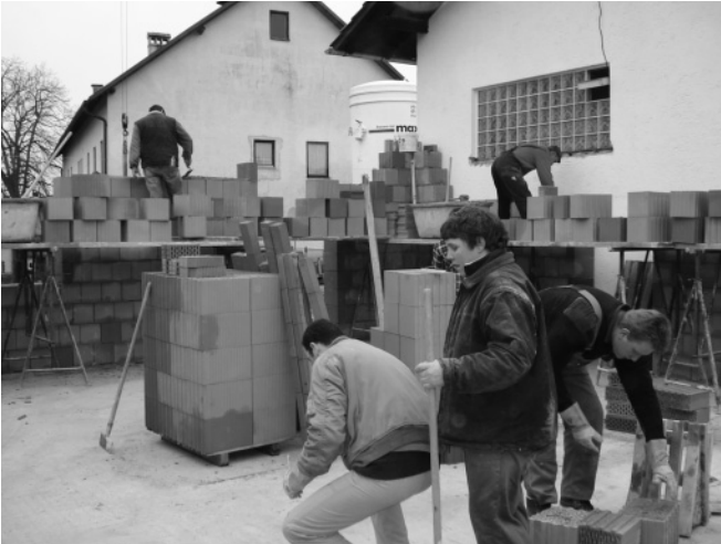
Fleißige Helfer beim Feuerwehrhausanbau
