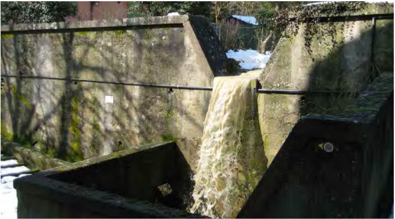
Fig. 24 – Il Rio della Valle in piena in seguito allo scioglimento delle nevi (6 marzo 2011). L'immagine ritrae la briglia in cemento a salto unico costruita nel 1939 a protezione dell'imboccatura del tombamento del corso d'acqua (foto S. Piastra).
