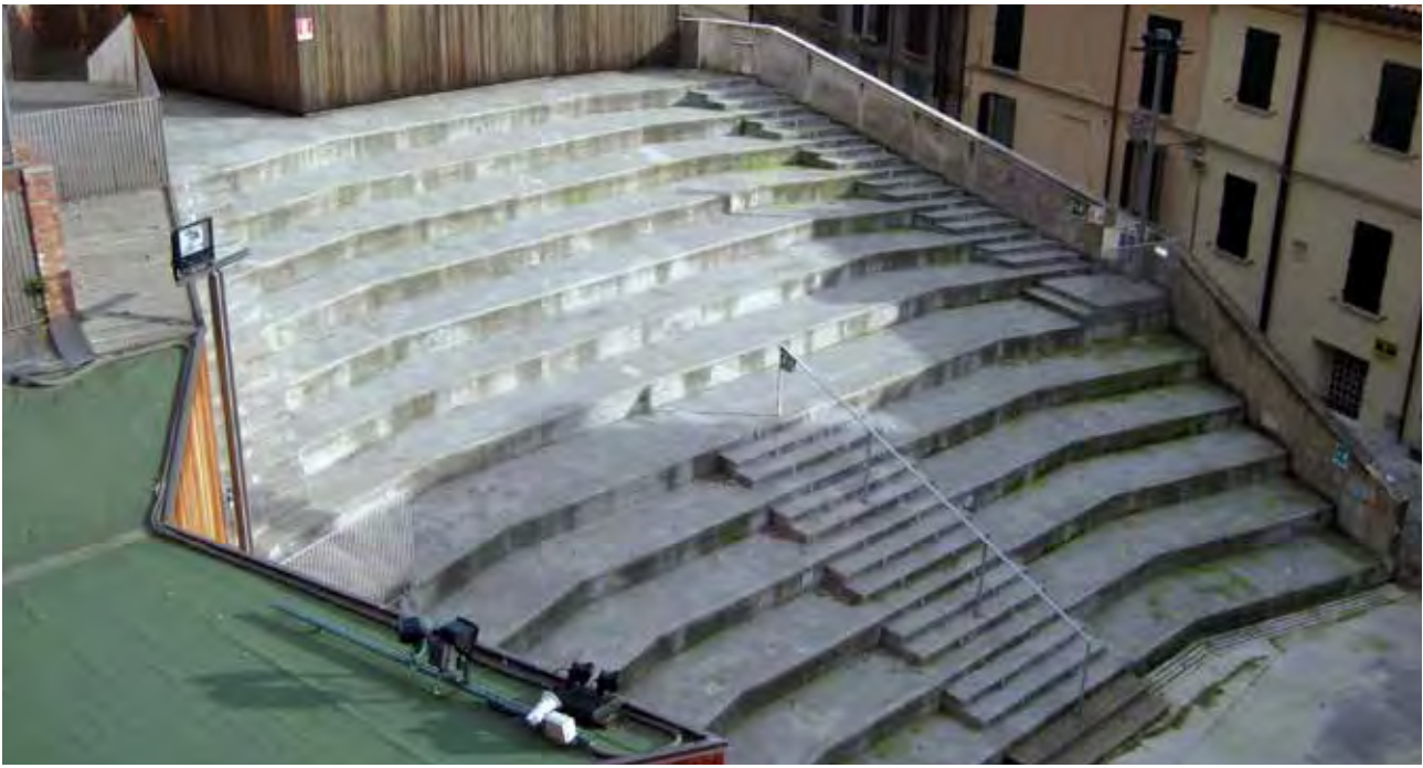
Fig. 40 – Il teatro all’aperto di via Spada, realizzato alla metà degli anni ‘80 del Novecento in corrispondenza del sito dove era ubicato Palazzo Spada, crollato parzialmente nel 1964 e successivamente abbattuto. La struttura appare molto discutibile sotto il profilo della sua pertinenza e integrazione all’interno del paesaggio urbano brisighellese (foto S. Piastra).
