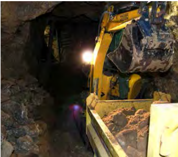
Fig. 7 – Sistemazione dell'ingresso di visita alla Tanaccia (foto A. Noferini).
