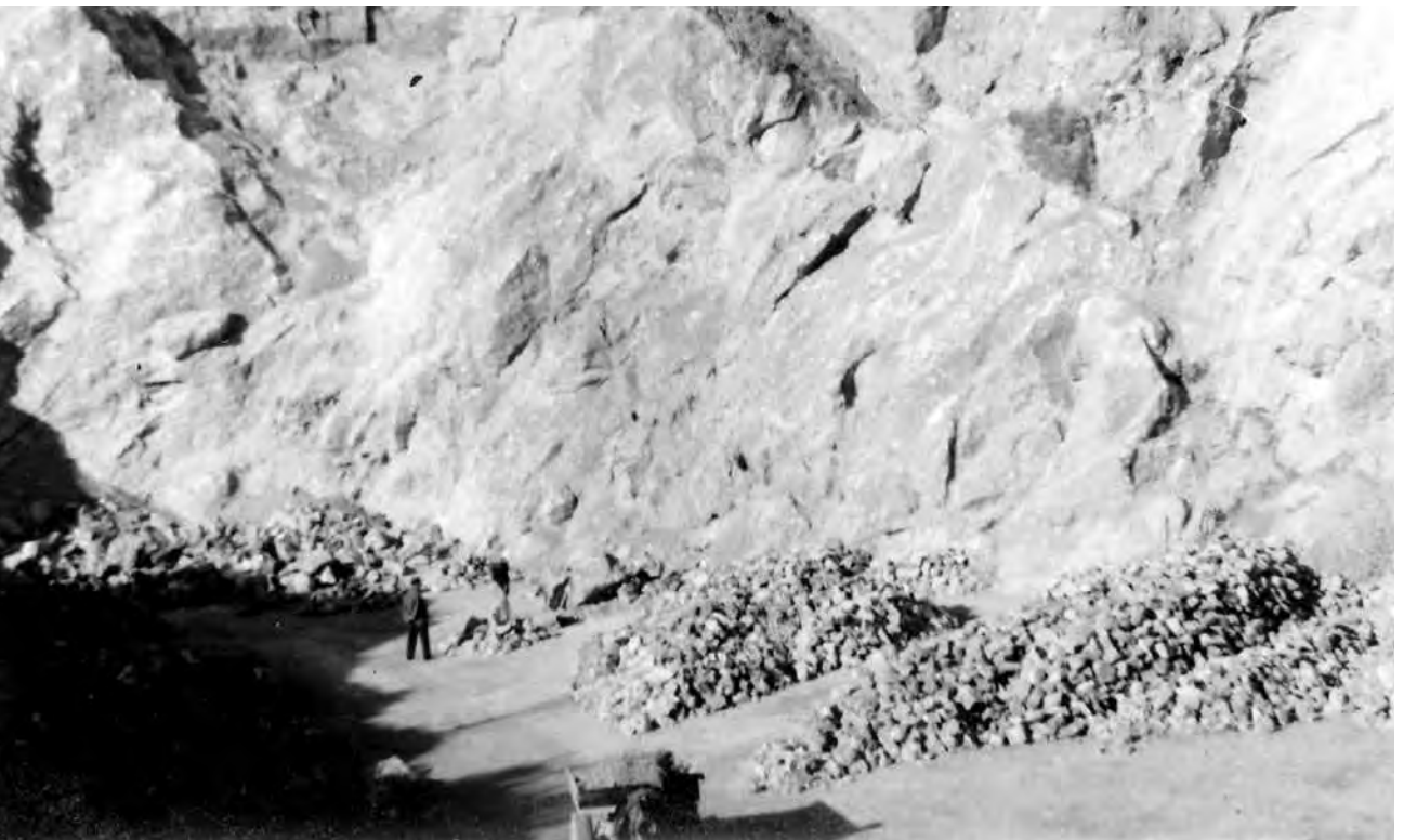
Fig. 57 – ARCHIVIO PRIVATO FAMIGLIA ZERBATO. Cava del Monticino: operai presso cumuli di pezzame gessoso da destinare alla cottura nella fornace del "Molinone". In basso al centro, un biroccio a trazione animale, carico di blocchi di gesso, si sta dirigendo verso la stazione di monte della teleferica. Anni '50 del Novecento.
