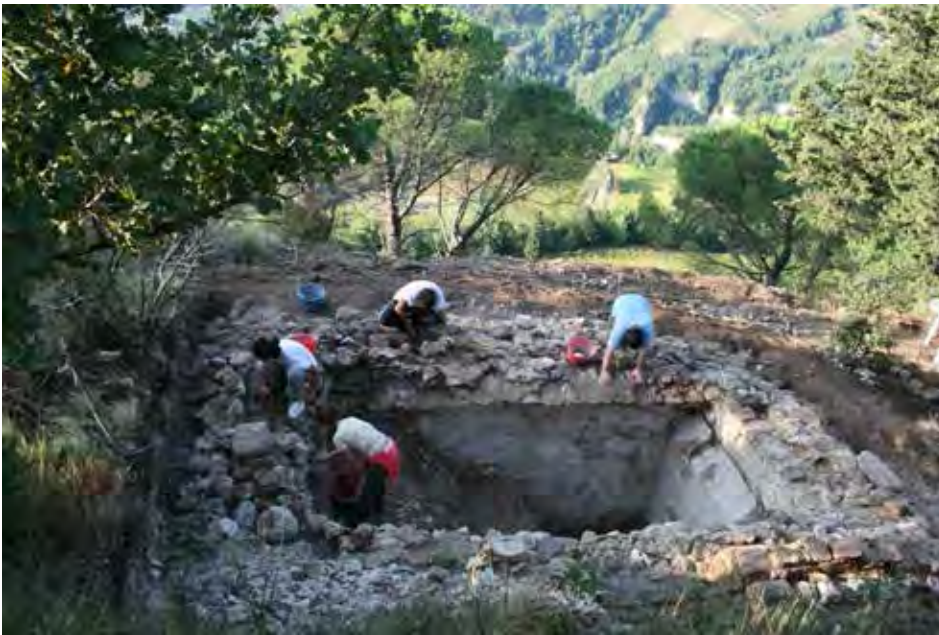
Fig. 28 – Casa-torre individuata sul versante meridionale del castello di Rontana, a ridosso del muro di cinta (foto E. Cirelli).
