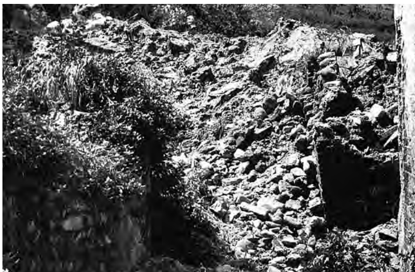
Fig. 21 – Frana del 1939 nella valle cieca del Rio della Valle, la quale distrusse alcune abitazioni alle spalle del Municipio e fu alla base di ulteriori sventramenti nell'area (da AA.Vv. 1999).
