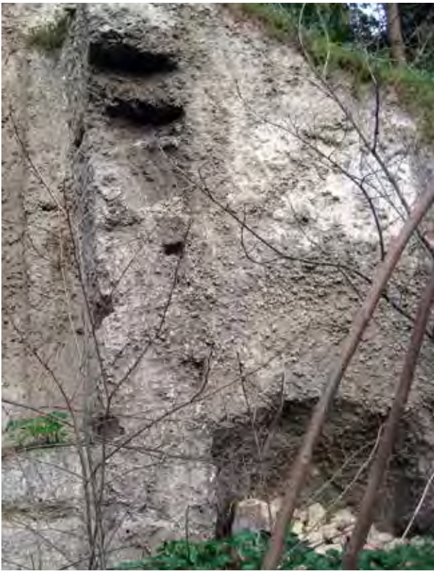
Fig. 35 – Ciò che resta oggi delle “casette della Rocca” abbattute nel 1923: mensole e scassi nella parete gessosa, originariamente posti negli interni dei vani posteriori delle abitazioni atterrate (foto S. Piastra).
