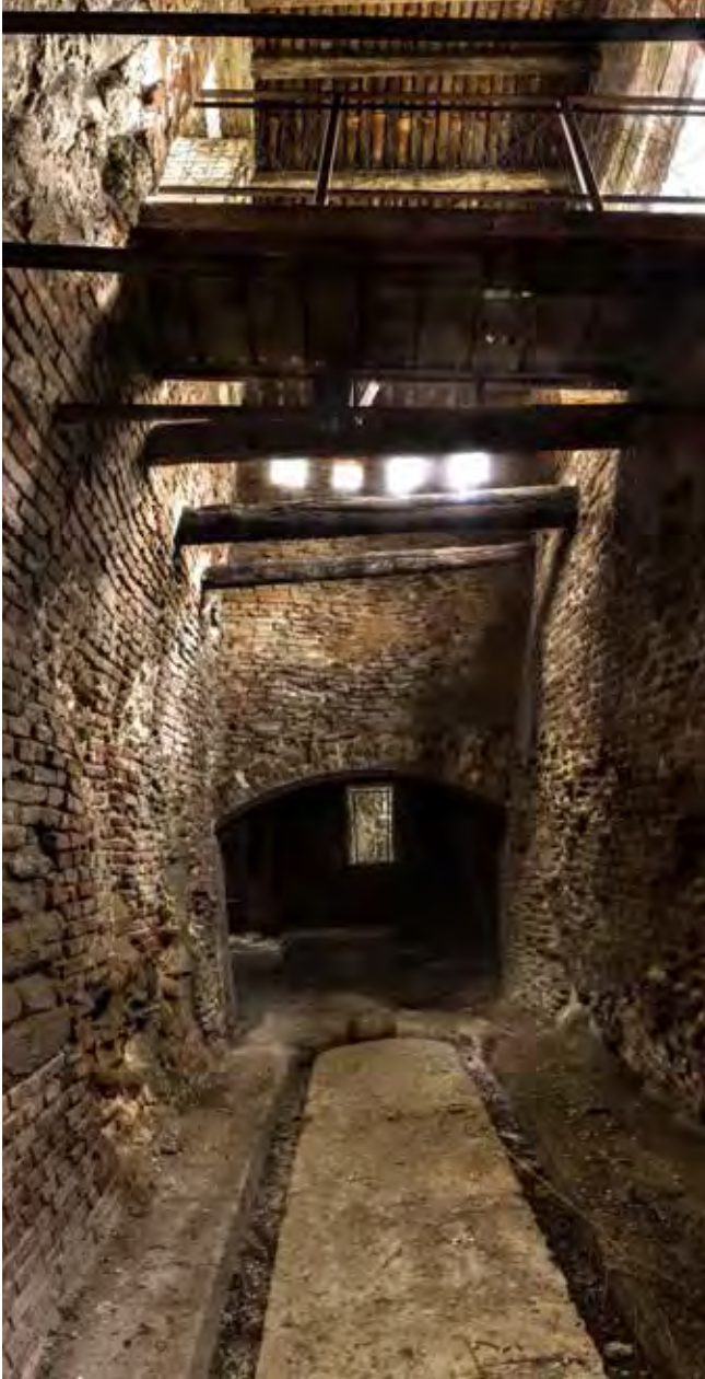
Figg. 6-7 – Il forno di cottura del gesso successivamente al restauro. In alto si nota la passerella di attraversamento, realizzata nell'ambito dell'intervento di recupero. Il "binario" visibile, a scasso, a terra va ricollegato al processo di combustione, probabilmente del carbon fossile (foto P. Lucci).
