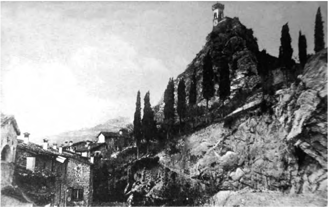
Fig. 5 – Il sito estrattivo di Gabalo, sito in un terreno di proprietà Metelli e gestito dalla famiglia Casadio, in una fotografia degli inizi del XX secolo (da Aa.Vv. 2001). A conferma delle precarie condizioni di sicurezza, sulla destra dell'immagine è individuabile un grosso masso di gesso aggettante.
