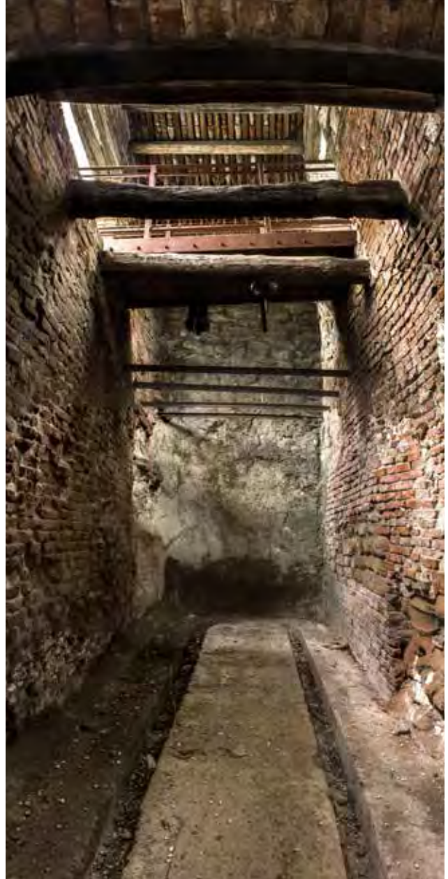
Figg. 6-7 – Il forno di cottura del gesso successivamente al restauro. In alto si nota la passerella di attraversamento, realizzata nell'ambito dell'intervento di recupero. Il "binario" visibile, a scasso, a terra va ricollegato al processo di combustione, probabilmente del carbon fossile (foto P. Lucci).
