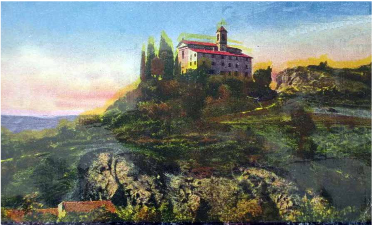
Fig. 54 – Cartolina in pseudocolori, databile probabilmente ai tardi anni '20-anni '30 del XX secolo: in primissimo piano sono visibili l'abitazione e l'opificio Carroli, assieme ad un fronte estrattivo; alle spalle del Santuario si scorge invece il nuovo fronte di escavazione della cava del Monticino, all'epoca forse ancora gestita dalla Bracchini & C. oppure, più verosimilmente, già sotto la gestione S.I.R.
