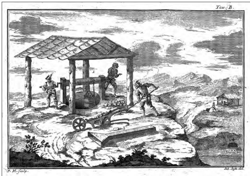
Fig. 1 – «Capanna» a protezione dell’imboccatura di un pozzo di una miniera di zolfo (da MASINI 1762). Il rogito notarile del 10 maggio 1703, in cui per la prima volta si menziona una solfatara presso Ca’ Cavulla (Brisighella), utilizza tale termine, il quale fa probabilmente riferimento a una struttura di questo tipo o alla struttura di protezione di un “Doppione” (vedi fig. 2).
