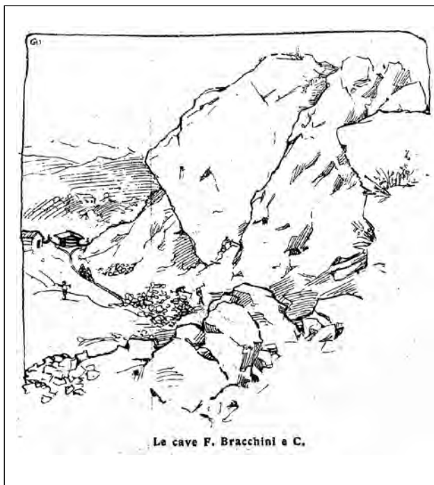
Fig. 51 – Disegno di G. Ugonia dei primi anni '20 del Novecento relativo alla cava del Monticino, all'epoca gestita dalla Bracchini & C. L'enorme masso aggettante ribadisce le precarie condizioni di sicurezza; alla base del medesimo masso è individuabile un "gessarolo" intento nell'opera di riduzione, col solo piccone, del volume del pezzo gessoso, da destinare poi alla cottura. Sempre nello stesso disegno, emerge come, a quel tempo, i blocchi fossero avviati tramite decauville a trazione umana alla stazione di monte della teleferica a contrappeso, la quale recapitava il minerale al "Molinone" (da ANONIMO 1921; già pubblicato in PIASTRA 2007).
