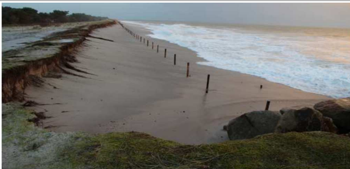
Exemple d'érosion à l'extrémité d'un ouvrage en enrochement – cordon dunaire à Fouesnant février 2014 ©Télégramme
