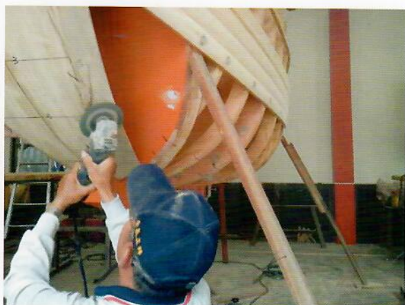
刨整、打磨船肋及各處，使船殼板固定後能平整，不致有凹凸。
