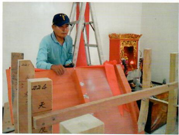
自「後營」拉線至船艙，觀察船艙間的中心 是否在同一直線上。
