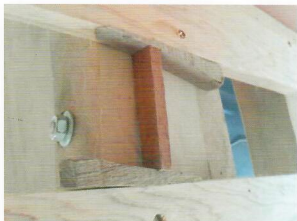
用角料支撐，固定間隔。
