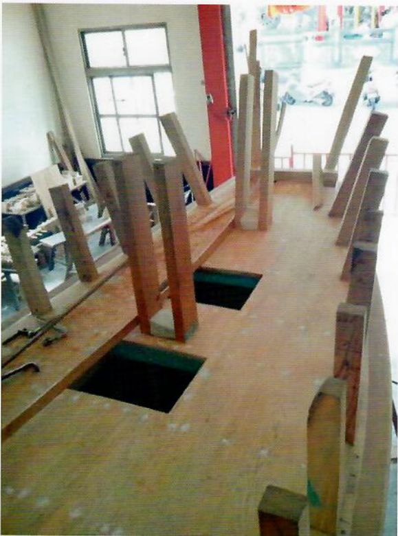
甲板安裝完成
