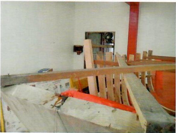
角料交叉釘在船肋上暫時固定船艙
