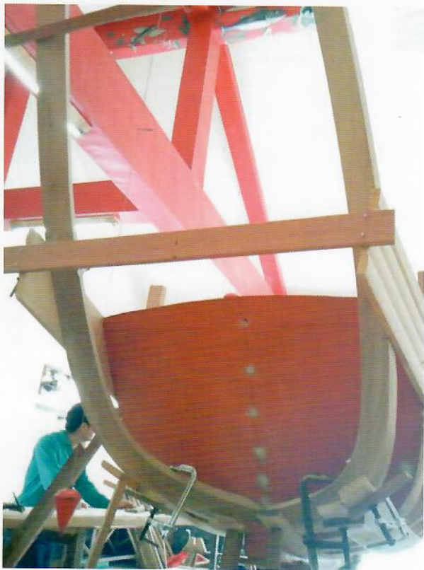
「翅仔尾」支撐船肋安裝完成
