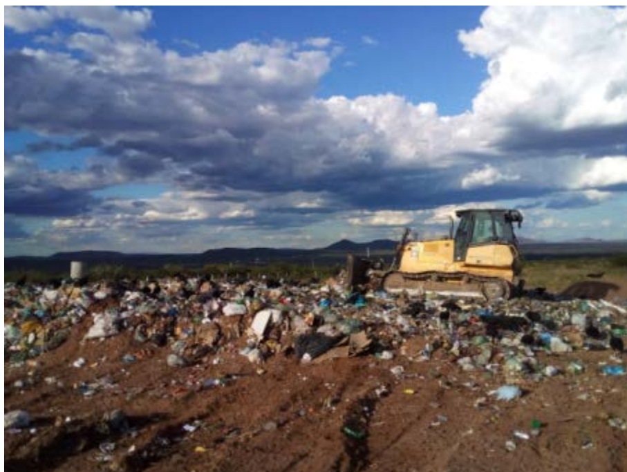
Figura 98– Operacionalização do Aterro Sanitário. Fonte: INSTITUTO GESOIS, 2021.
