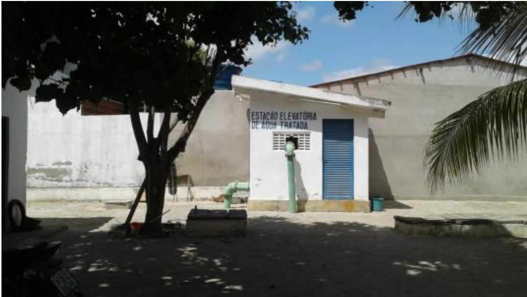
Figura 39 – EEAT Poço C2 SAA COMPESA Fonte: INSTITUTO GESOIS, 2021.
