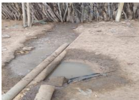
Figura 60 – Esgoto do Sítio Salgado Fonte: INSTITUTO GESOIS, 2021.
