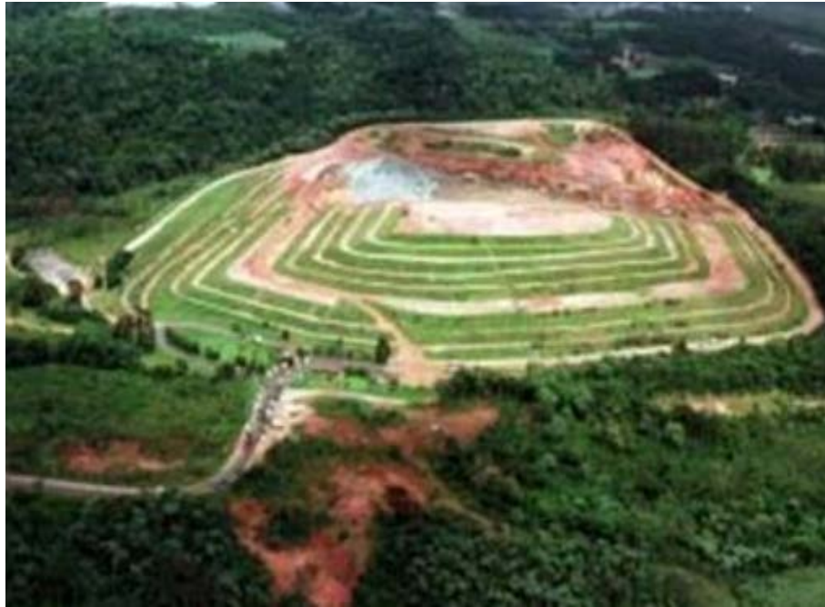
Figura 93– Aterro Sanitário. Fonte: INSTITUTO GESOIS, 2017.
