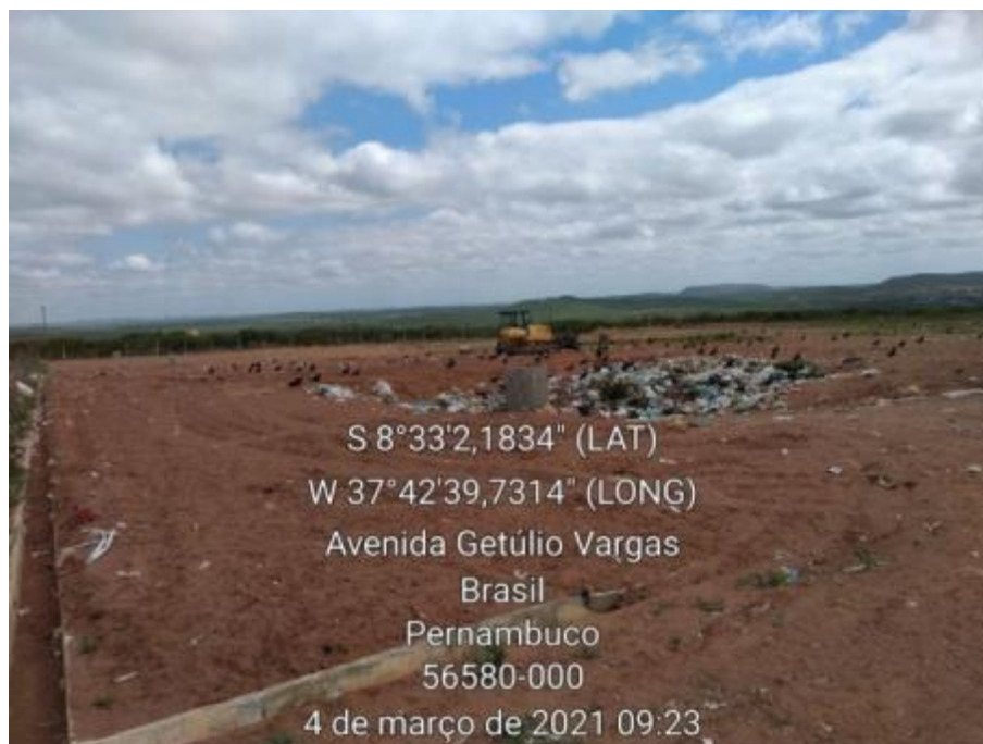
Figura 99–Aterro Sanitário. Fonte: INSTITUTO GESOIS, 2021.
