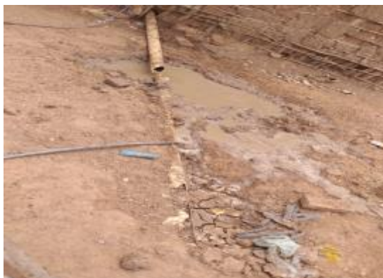
Figura 58 – Esgoto do Sítio Salgado Fonte: INSTITUTO GESOIS, 2021.
