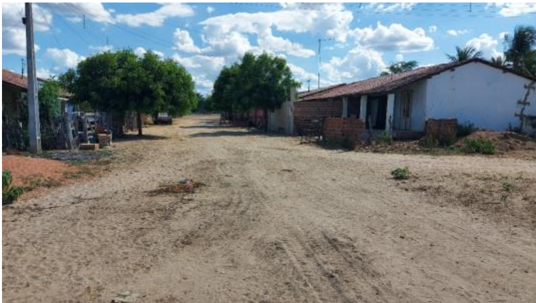
Figura 135 – Agrovila VIII com ausência de sistema de drenagem Fonte: INSTITUTO GESOIS, 2020.
