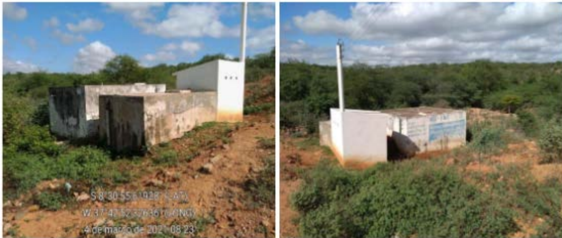
Figura 52 – Poço de Cajá, no Povoado Poço da Cruz Fonte: INSTITUTO GESOIS, 2021.
