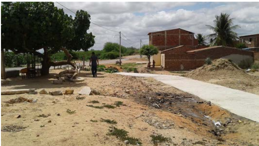
Figura 127 – Obra de infraestrutura sem a devida manutenção, com resíduos queimados em seu entorno Fonte: INSTITUTO GESOIS, 2020.
