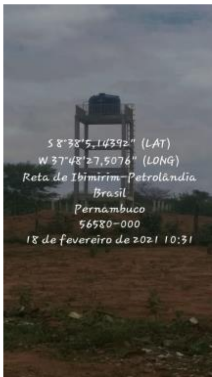
Figura 62 – Poço Aldeia Nazario Fonte: INSTITUTO GESOIS, 2021.
