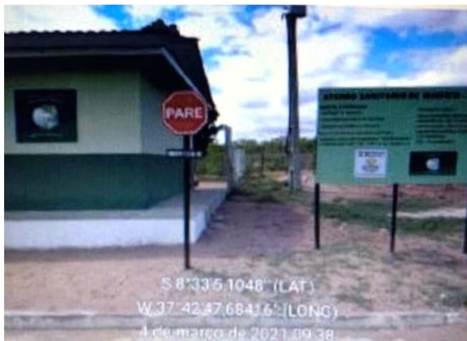
Figura 94– Entrada do Aterro Sanitário. Fonte: INSTITUTO GESOIS, 2021.
