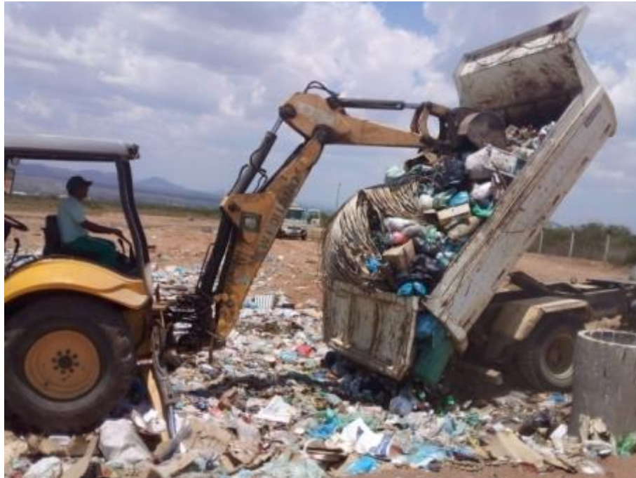
Figura 97– Operacionalização do Aterro Sanitário. Fonte: INSTITUTO GESOIS, 2021.
