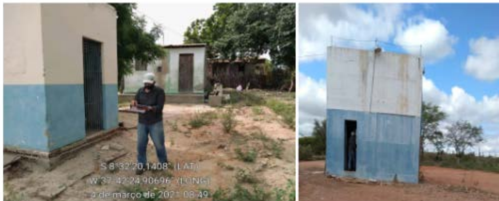
Figura 51 – Poço de Cajá, no Povoado Poço da Cruz Fonte: INSTITUTO GESOIS, 2021.
