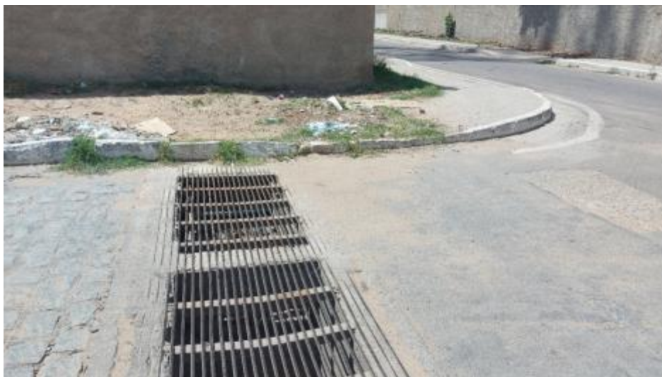
Figura 122 – Boca de Leão vista por outro ângulo Fonte: INSTITUTO GESOIS, 2020.
