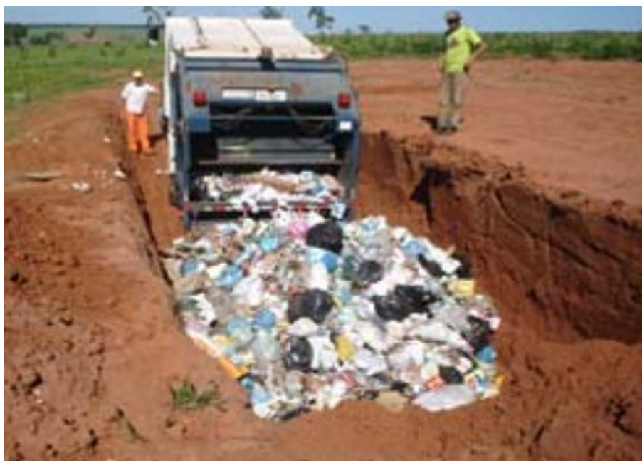
Figura 92 – Aterro Controlado. Fonte: INSTITUTO GESOIS, 2017.
