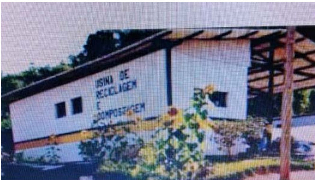
Figura 82– Unidade de Triagem e Compostagem-Processo de Baixo Custo Fonte: PEREIRA NETO, 1996.
