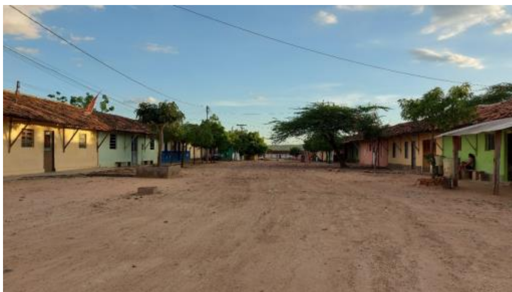
Figura 132 – Poço da Cruz ausência de sistema de drenagem Fonte: INSTITUTO GESOIS, 2020.
