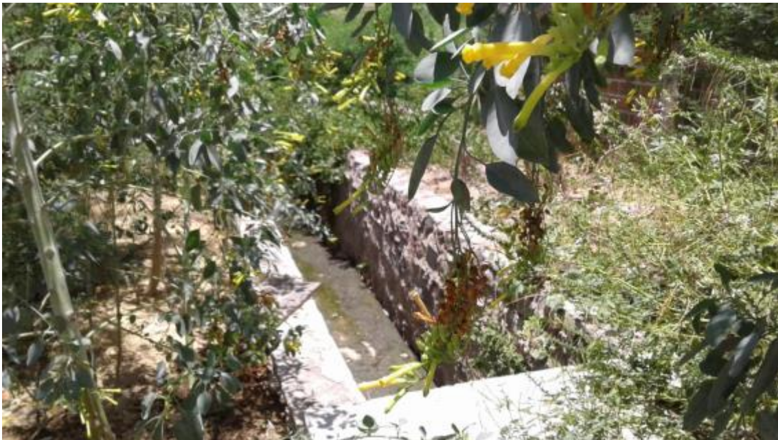
Figura 68 – Lançamento de Esgotamento no Rio Moxotó Fonte: INSTITUTO GESOIS, 2021.
