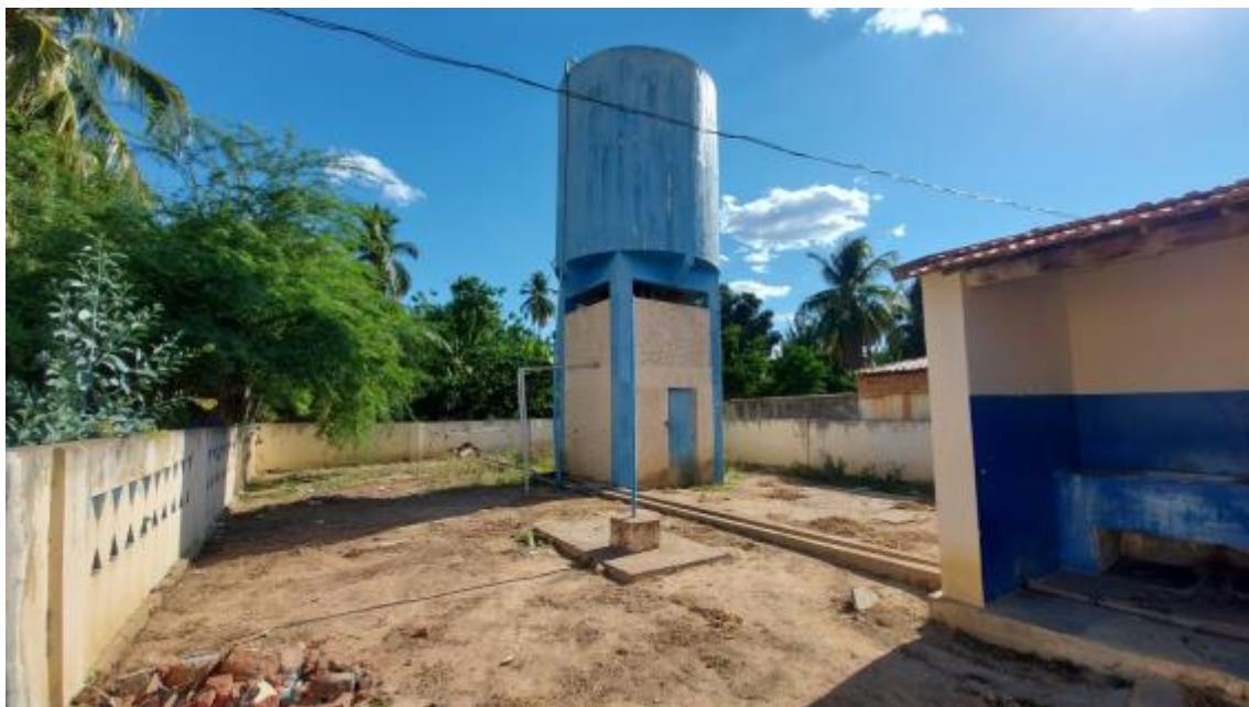
Figura 46 – Reservatório no Distrito do Moxotó Fonte: INSTITUTO GESOIS, 2021.
