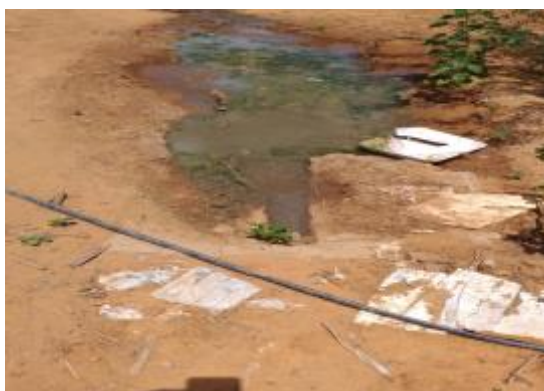
Figura 59 – Esgoto do Sítio Salgado Fonte: INSTITUTO GESOIS, 2021.
